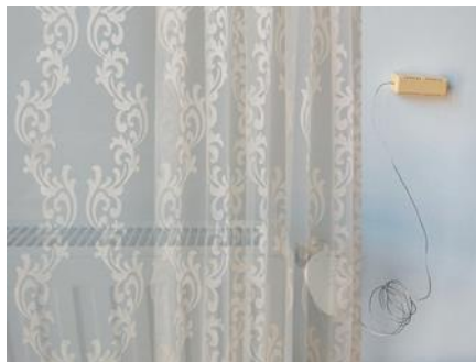
Рис. 30 – Термостатична головка з виносним датчиком
