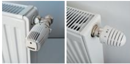
Рис. 29 – Термостатична головка в вертикальному положенні
