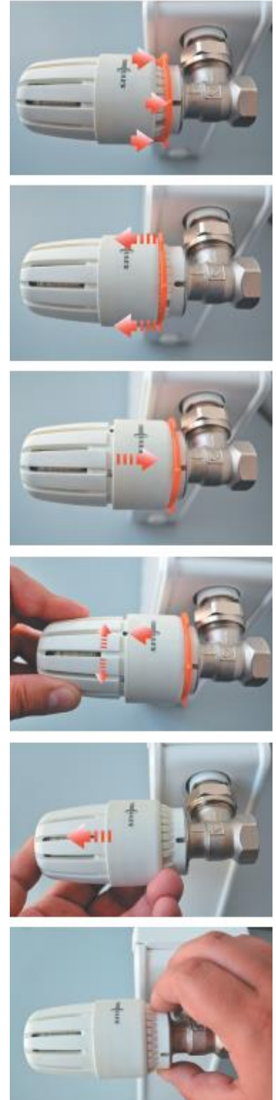
Рис. 37 – Метод налаштування термоголовки
