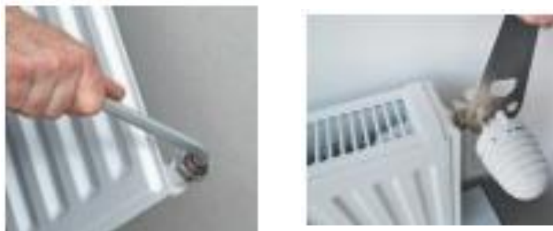
Рис. 25 – Метод підключення термостатичного клапана
