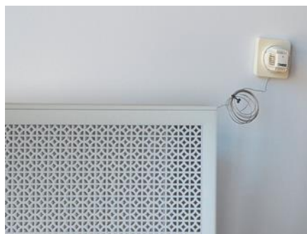
Рис. 31 – Термостатична головка з дистанційним регулюванням
