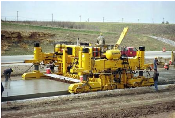
Рисунок 2.9 – Ущільнення бетонної суміші і обробка поверхні покриття при роботі машин з ковзаючими формами
