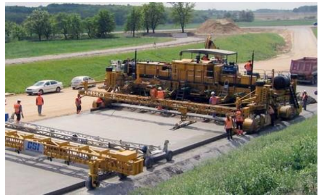
Рисунок 2.9 – Ущільнення бетонної суміші і обробка поверхні покриття при роботі машин з ковзаючими формами
