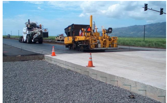
Рисунок 1.1 – Улаштування цементобетонного покриття
