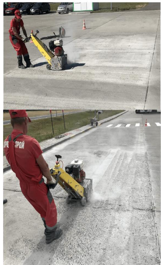
Рисунок 4.2 - Технологія усунення лущення цементобетонного покриття
