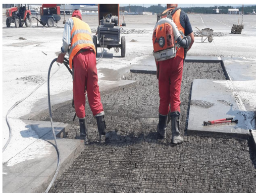
Рисунок 4.2 - Технологія усунення лущення цементобетонного покриття
