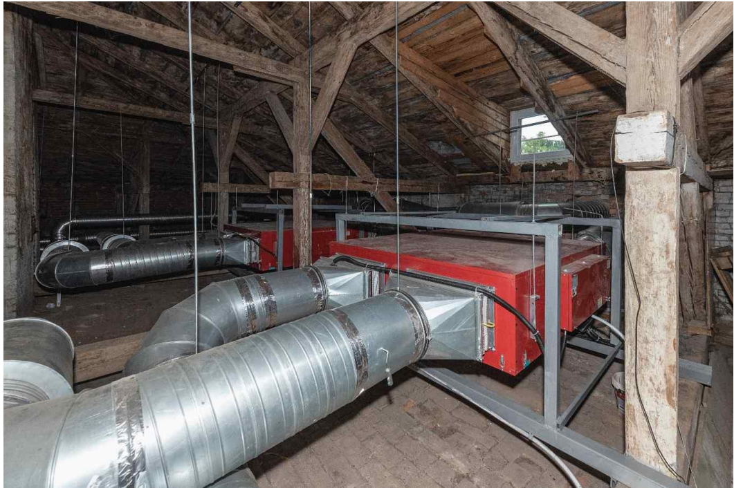
Рисунок 1.11 - Приливоно-витяжна установка
