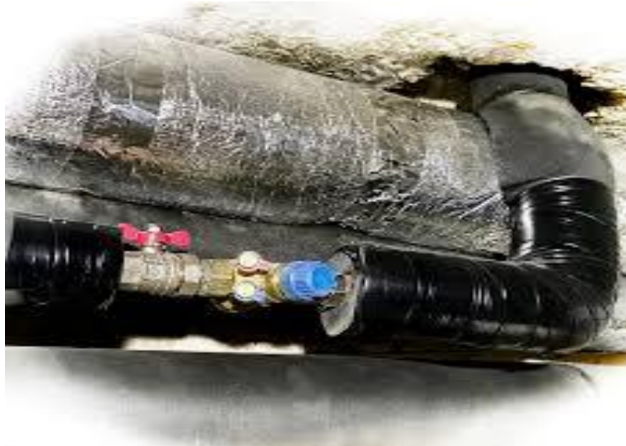
Рисунок 1.12 - Утеплення магістральних трубопроводів
