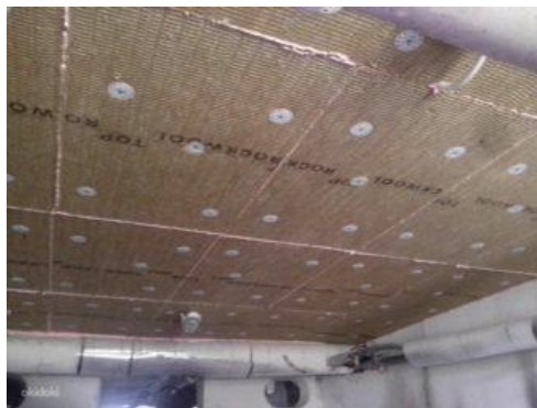
Рисунок 1.6 - Утеплення перекриття підвалу
