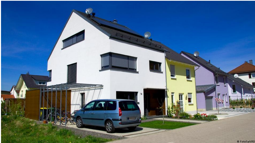
Рисунок 2.1 - Будинок утеплений за технологією мокрий фасад
