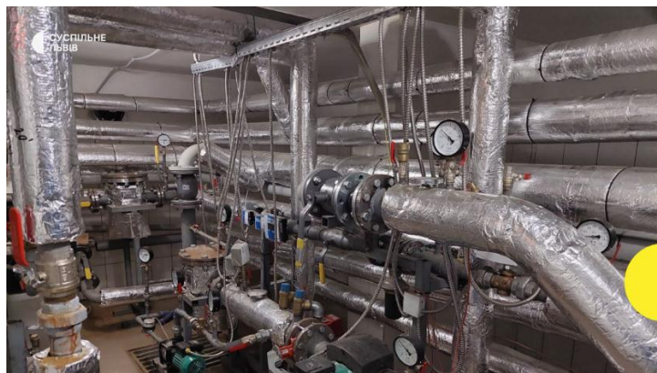
Рисунок 1.10 - Індивідуальний тепловий пункт ІТП
