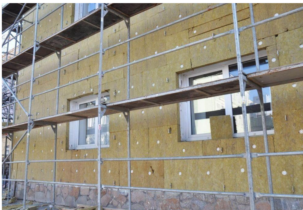
Рисунок 2.4 – Приклад кріплення мінеральної вати
