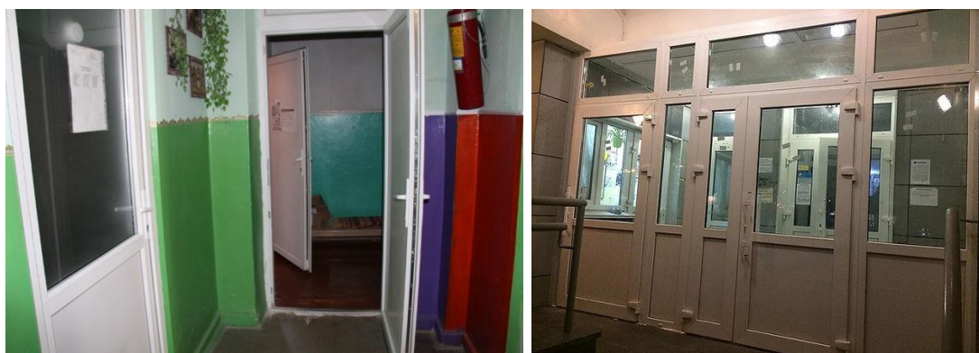
Рисунок 1.9 - Встановлення металопластикових дверей
