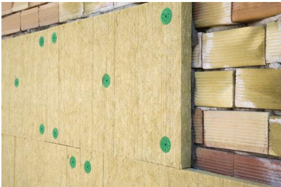
Рисунок 2.3 - Кріплення мінеральної вати
