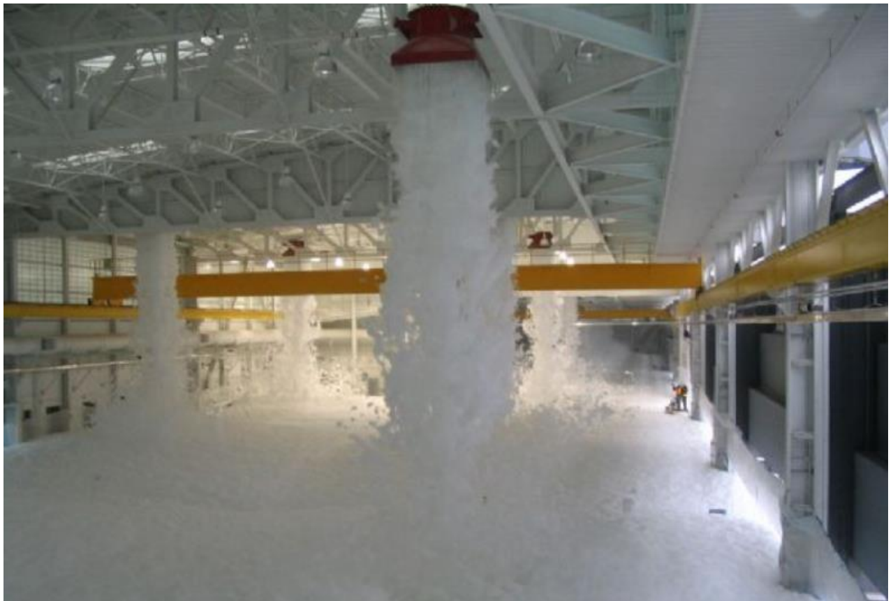
Рисунок 2.3 – Гасіння пожежі пінноповітряною сумішшю
