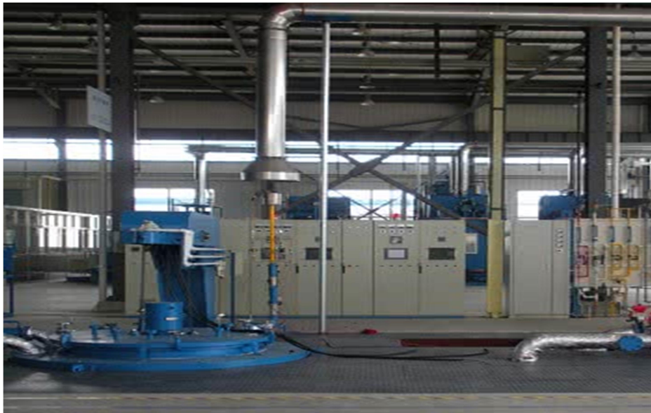
Рисунок 3.2 – Електропіч опору шахтна вакуумна моделі UPF–100150
