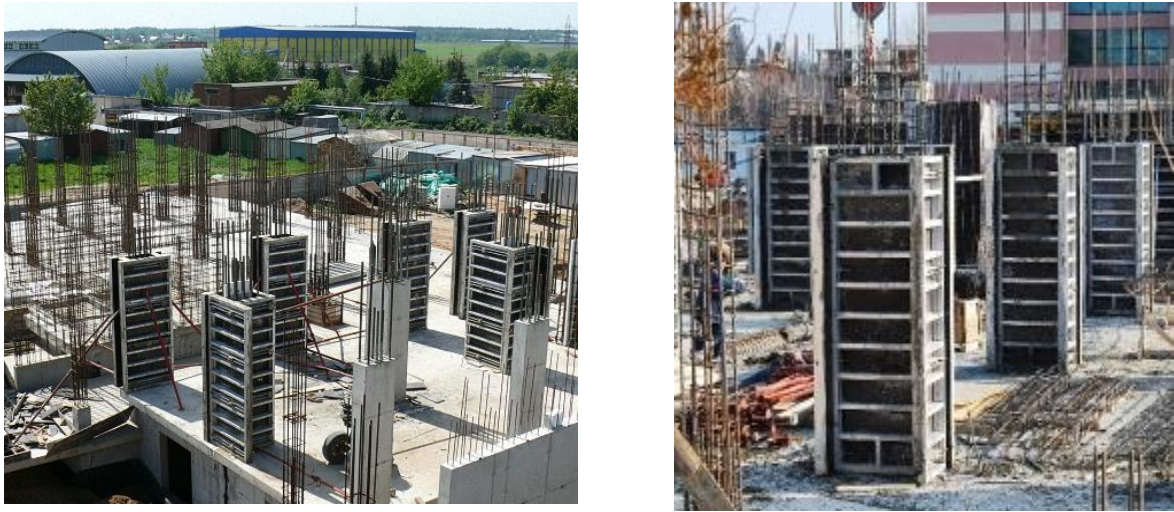
Рисунок 5.1 – Встановлення опалубки колон
