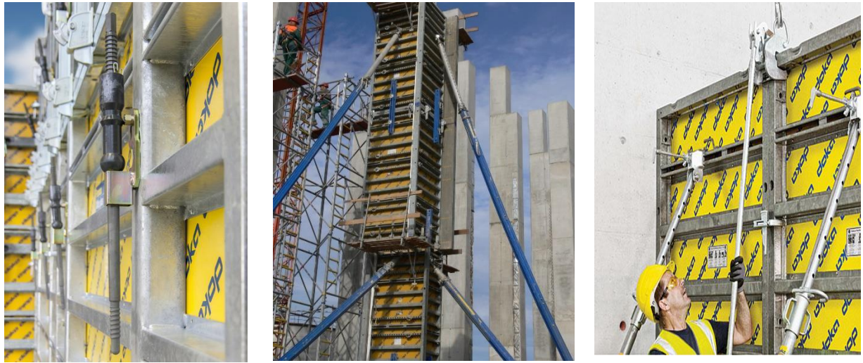
Рисунок 1.7 - Дрібнощитова опалубка «Framax» фірми «DOKA».
