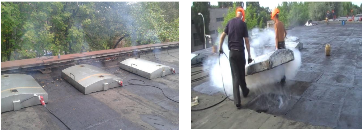
Рисунок 3.7 – Обладнання для нагрівання покрівлі при ремонті
