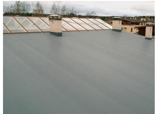
Рисунок 1.8 - Мембрана ПВХ та ТПО
