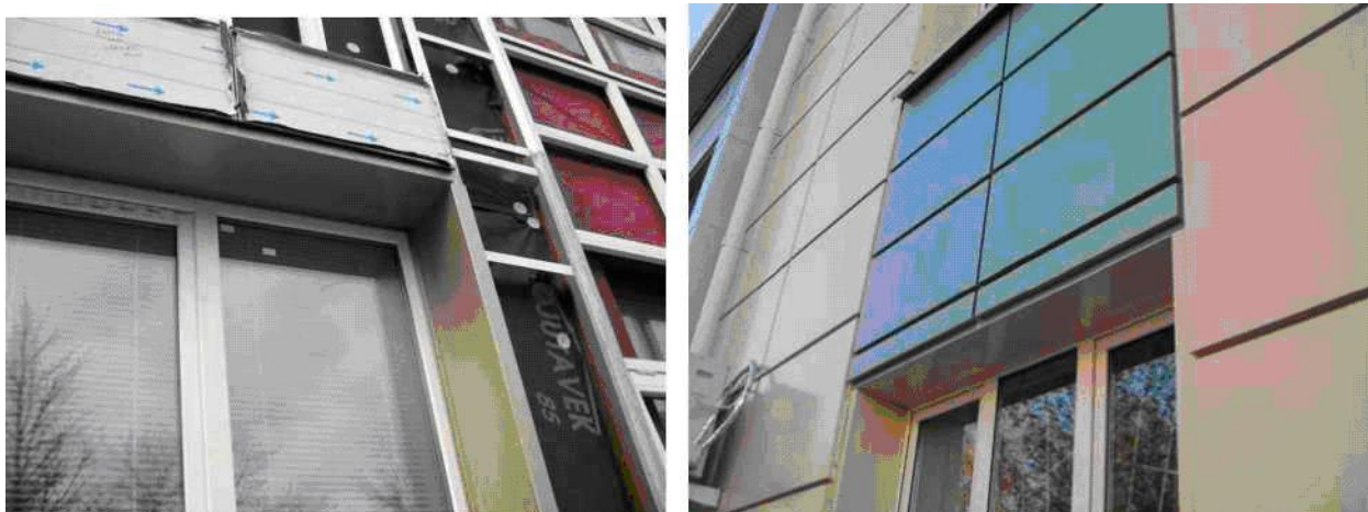
Рисунок 2.6 - Монтаж фасонних елементів
