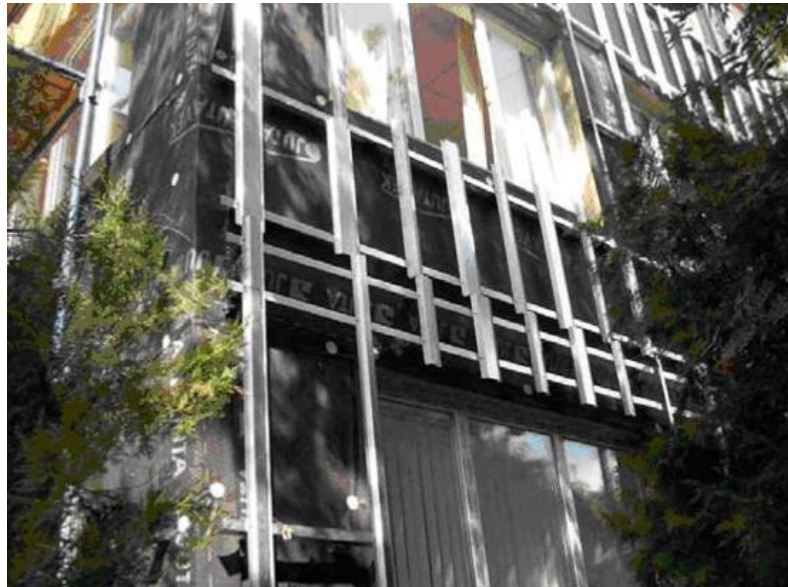
Рисунок 2.3 - Установка профілей
