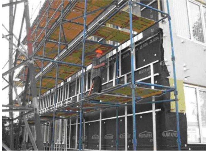
Рисунок 2.4 - Монтаж каркаса
