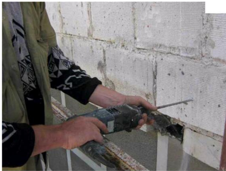
Рисунок 2.1 - Свердління отвору за допомогою електродрілі
