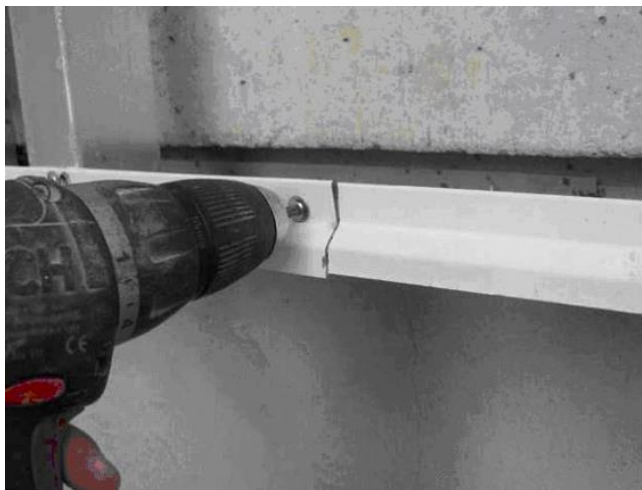
Рисунок 2.5 -Монтаж початкової планки
