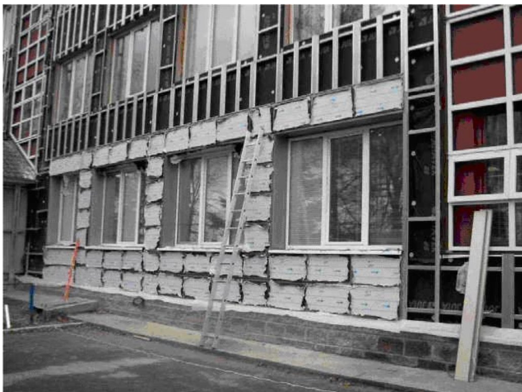
Рисунок 2.8 - Монтаж фасадних касет МП 2005 (2000)
