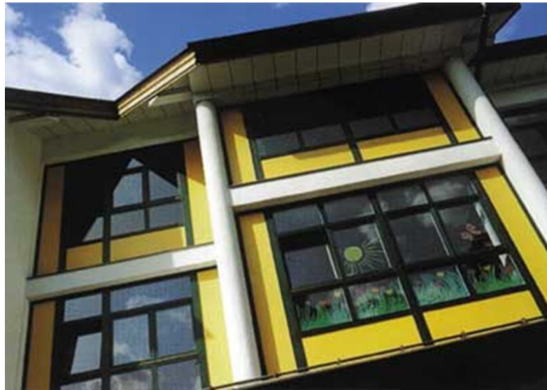
Рисунок 1.12 - Облицювання фасадів панелями MAX
