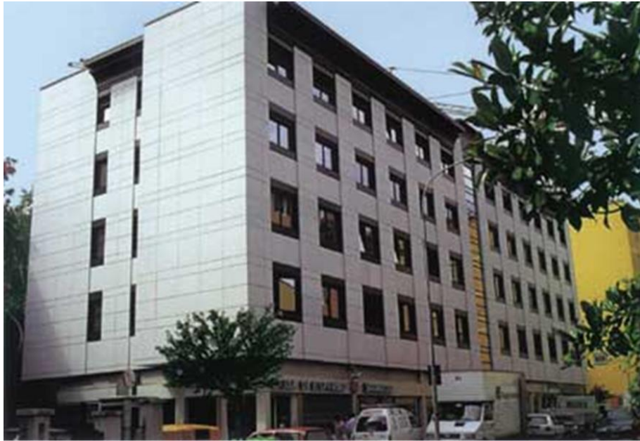
Рисунок 1.8 - Натуральний камінь для облицювання фасадів.
