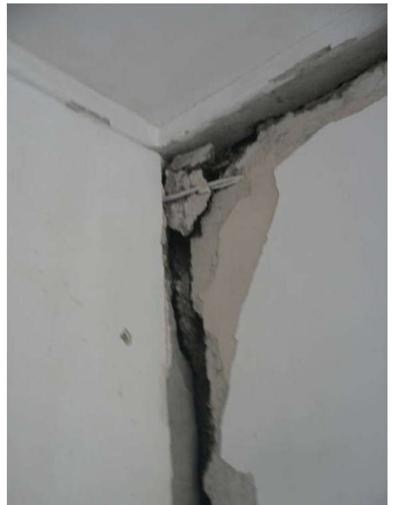
Рисунок 4.36 – Зміщення стінових панелей по осі «III/1» з утворенням зазорів та тріщин: а) кв. № 88; б) кв. № 96; в) кв. № 88; г) кв. № 84
