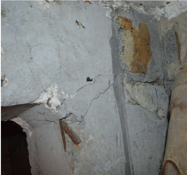
Рисунок 4.65 – Пошкодження та дефекти панелей технічного підпілля:
