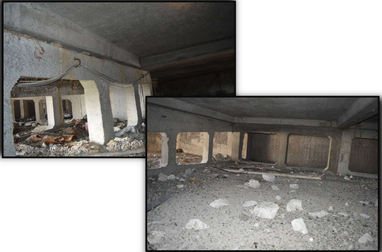
Рисунок 3.11 – Зовнішній вигляд конструкцій технічного поверху будівлі об'єкта
