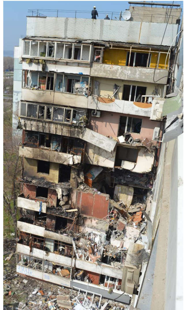
Рисунок 4.49 – Зовнішній вигляд під’їзду № 1 будівлі об’єкта № 2 (станом на 23.03.2023р.)
