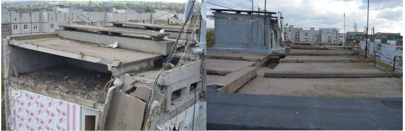
Рисунок 3.6 – Зовнішній вигляд технічного поверху, покриття та безрулонної покрівлі будівлі об'єкта № 1
