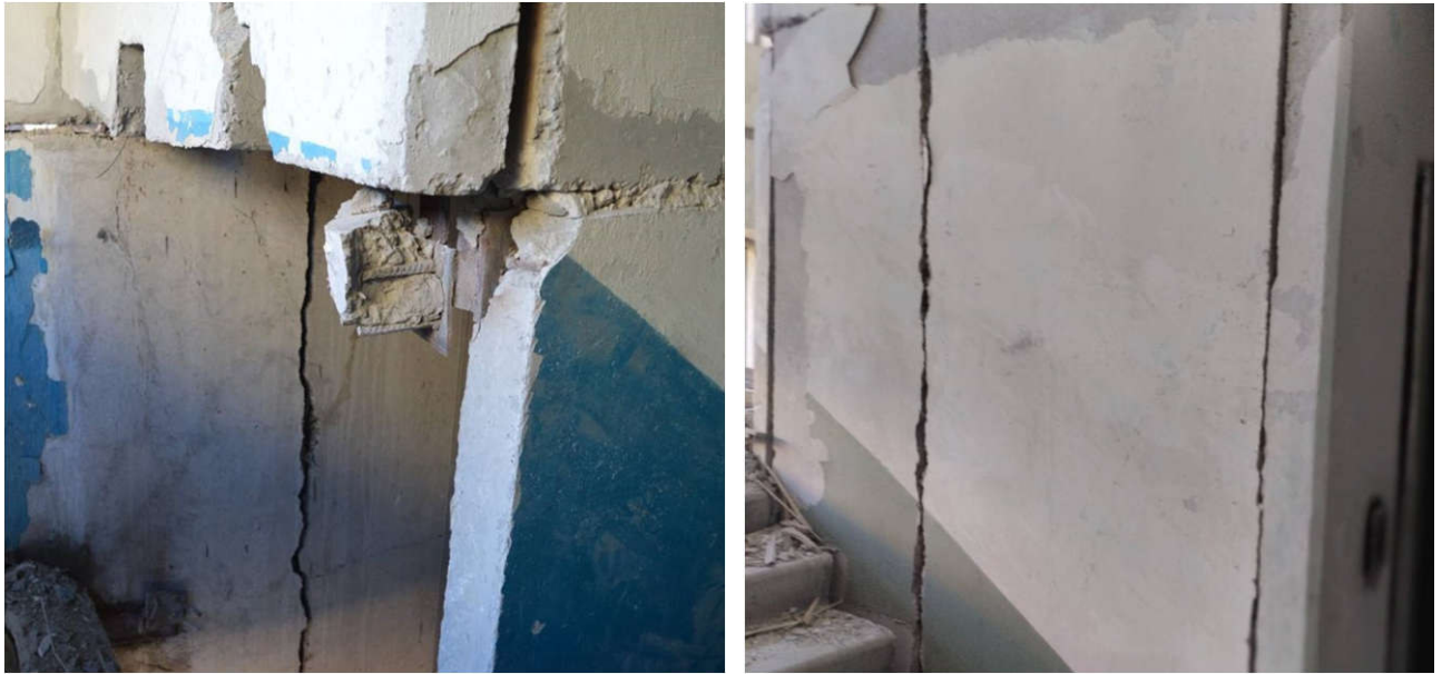
Рисунок 4.48 – Руйнація ліфтової шахти
