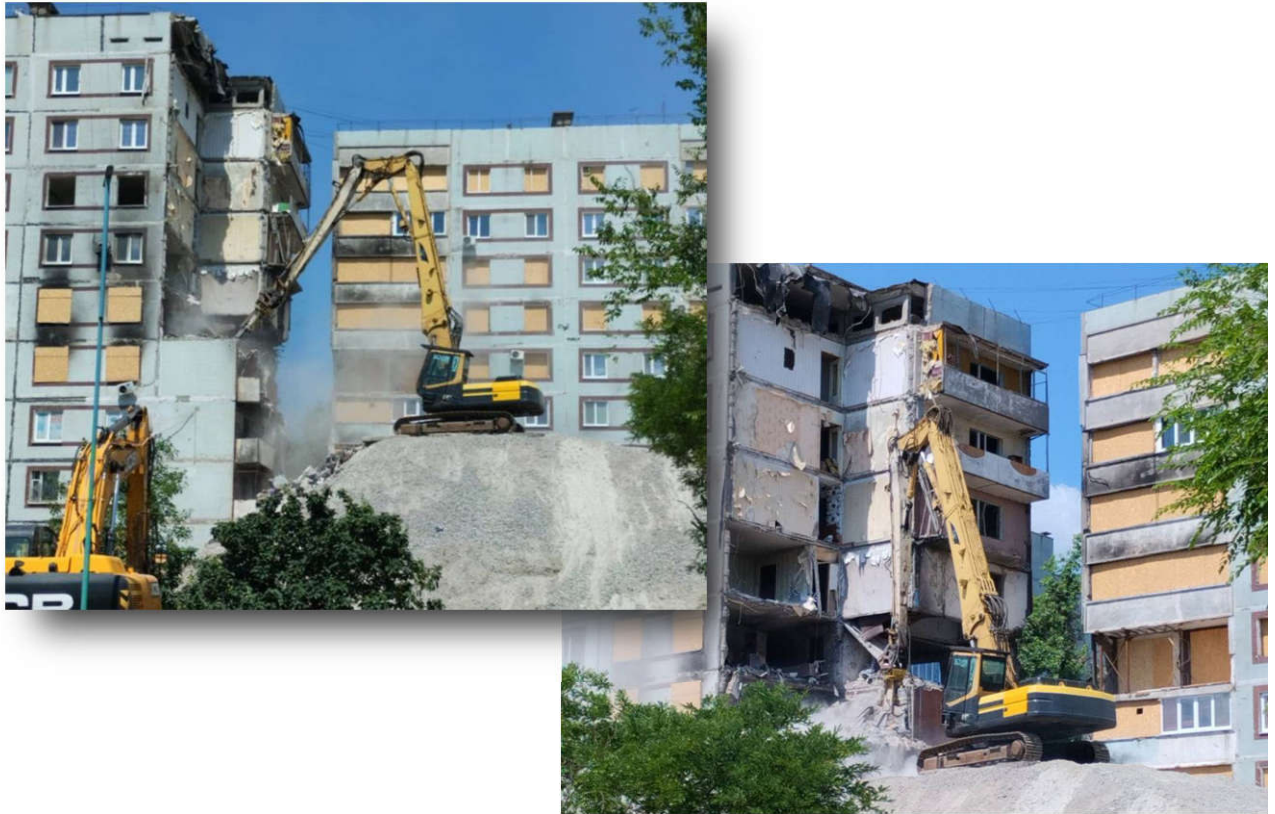
Рисунок 5.2 – Процес демонтажу будівельних конструкцій частини під'їзду № 1 будівлі об'єкта № 2
