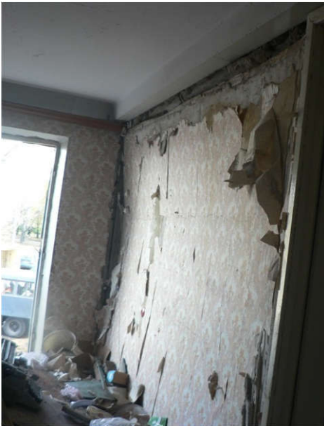
Рисунок 4.40 – Руйнація, вигини перегородок: а) кв. № 81; б) кв. № 80
