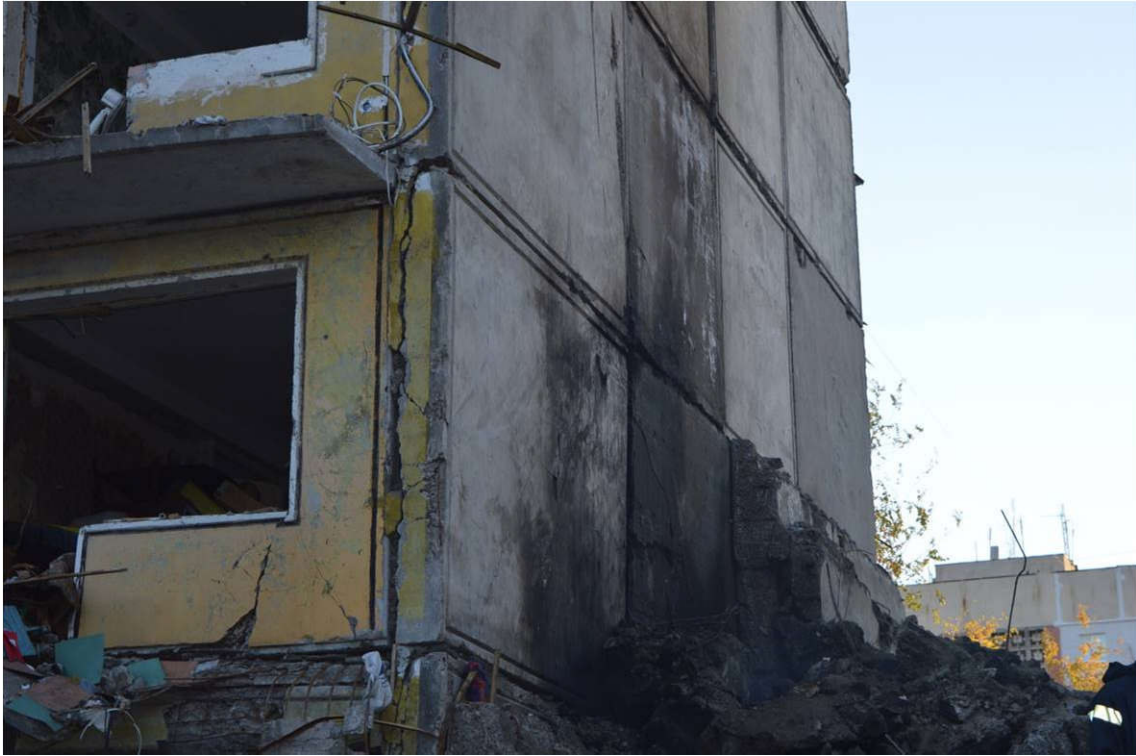
Рисунок 4.37 – Пошкодження панелей під дією полум'я та високих температур
