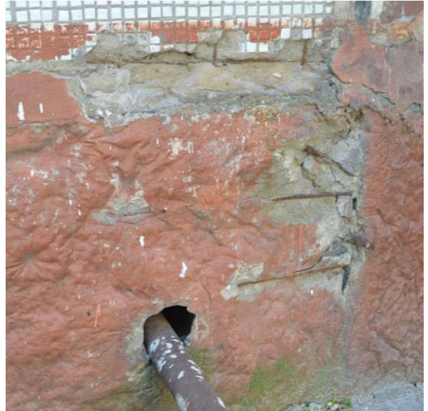
Рисунок 4.65 – Пошкодження та дефекти панелей технічного підпілля:
