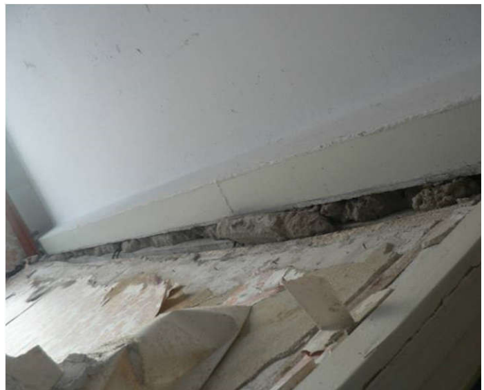
Рисунок 4.40 – Руйнація, вигини перегородок: а) кв. № 81; б) кв. № 80
