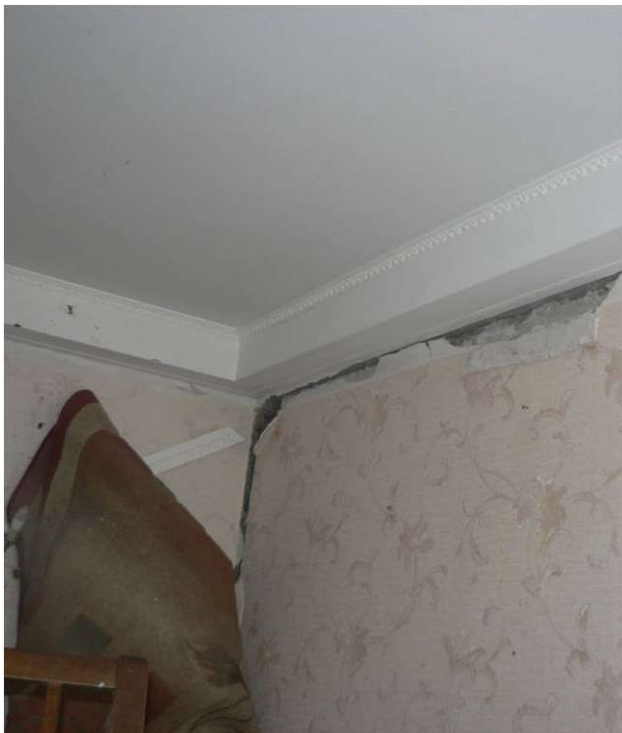
Рисунок 4.36 – Зміщення стінових панелей по осі «III/1» з утворенням зазорів та тріщин: а) кв. № 88; б) кв. № 96; в) кв. № 88; г) кв. № 84
