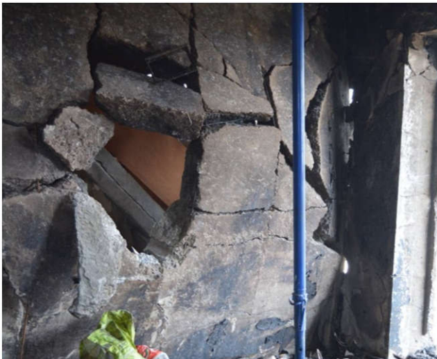
Рисунок 4.53 – Руйнація внутрішніх стінових панелей п'ятого поверху а) по ряду «Б»; б) по осі «б»
