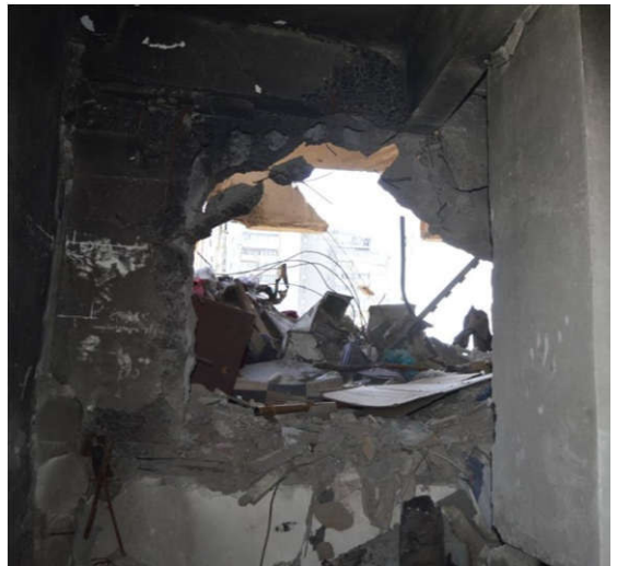
Рисунок 4.53 – Руйнація внутрішніх стінових панелей п'ятого поверху а) по ряду «Б»; б) по осі «б»
