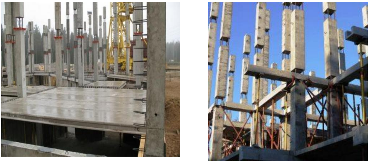
Рисунок 1.3 – Конструктивні елементи збірно-монолітний каркас
