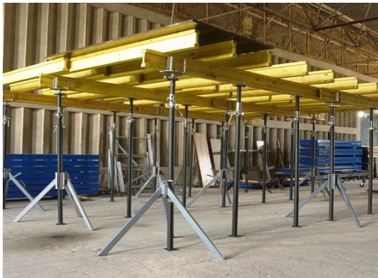
Рисунок 4.7 – Опалубка перекриття «ДОКА»
