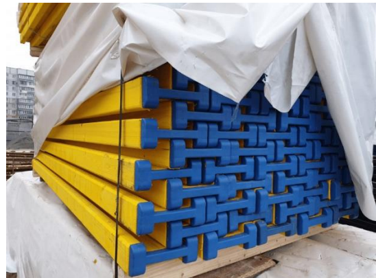
Рисунок 4.7 – Опалубка перекриття «ДОКА»
