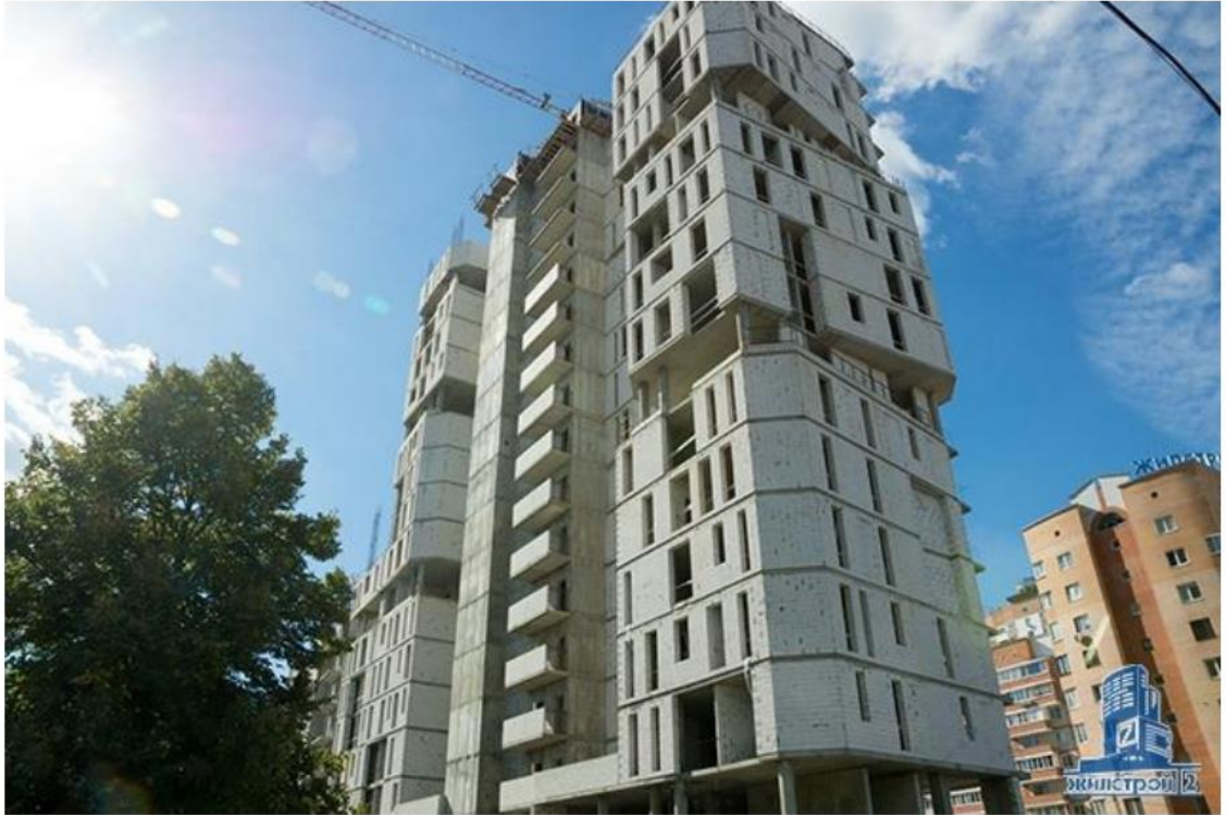
Рисунок 2.12 - Загальний вигляд будинку, що зводиться
