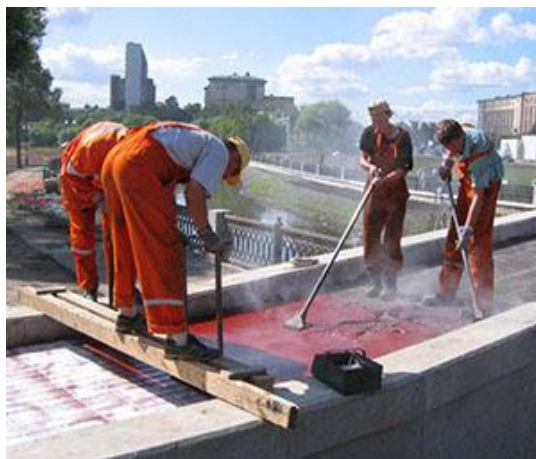
Рисунок 3.6 – Технологія влаштування покриття IMPRINT
