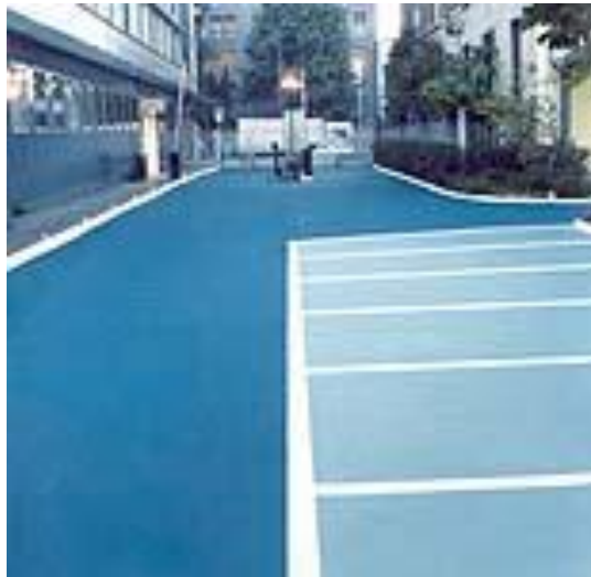
Рисунок 3.5 – Покриття з декоративного бетону
