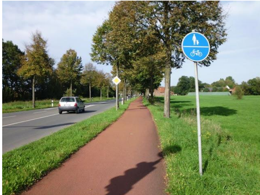
Рисунок 3.2 – Велосипедна смуга з покриттям із кольорового асфальтобетону
