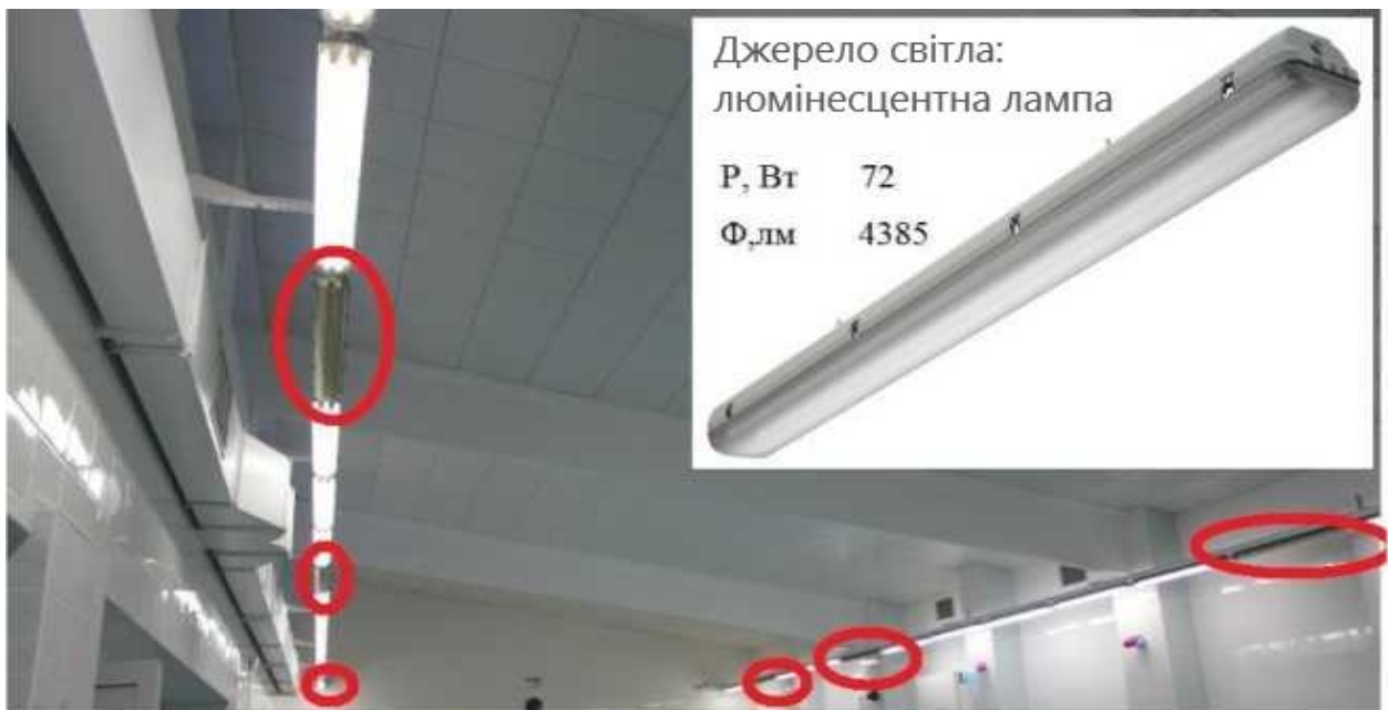
Рисунок 1.8 - Освітлювальна установка - 30 світлових приладів. Червоним овалом відмічені непрацюючі світлові прилади - 6 шт.
