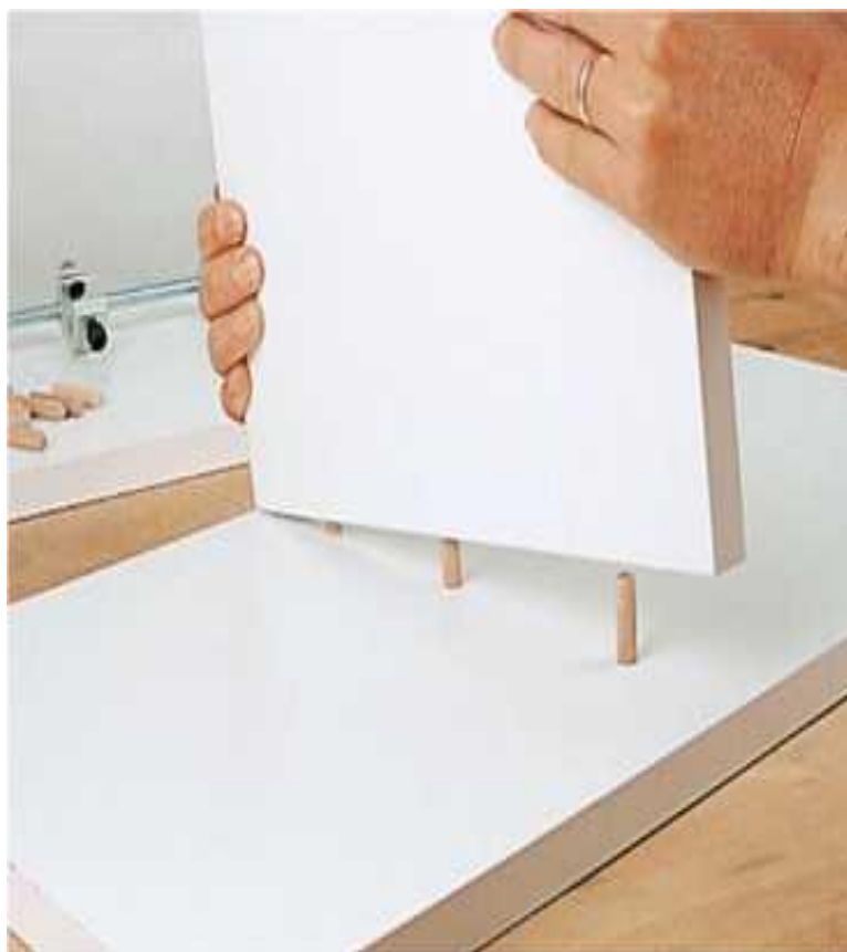
Рисунок 3.6 - Використання дерев'яних шкантів
