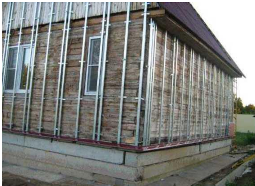
Рисунок 2.5. - Система направляючих для кріплення термопанелей
