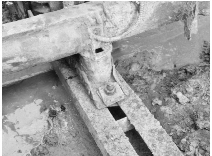
Рисунок 3.4 – Кріплення бурових
