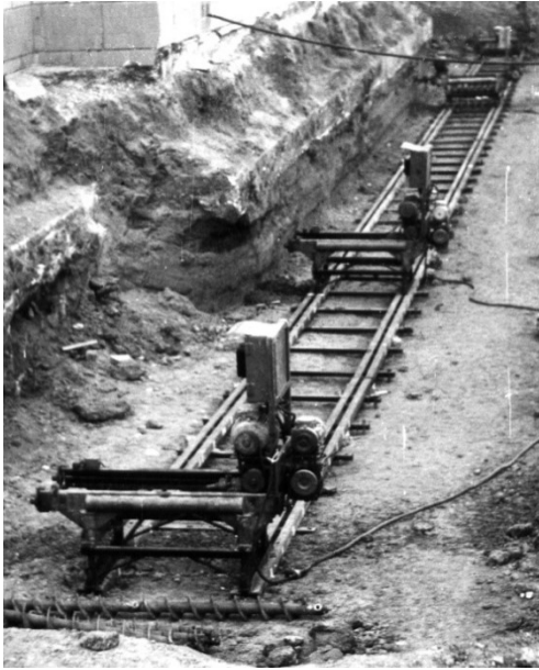
Рисунок 3.3 – Розміщення станків на рейкових коліях
