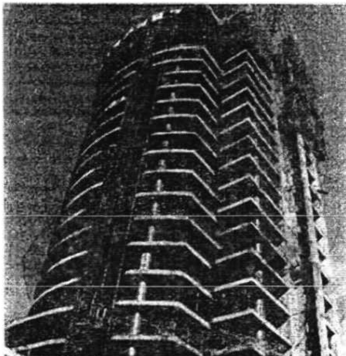
Рисунок 1.3 – Процес зведення будівлі «Tianjing Evening News»
