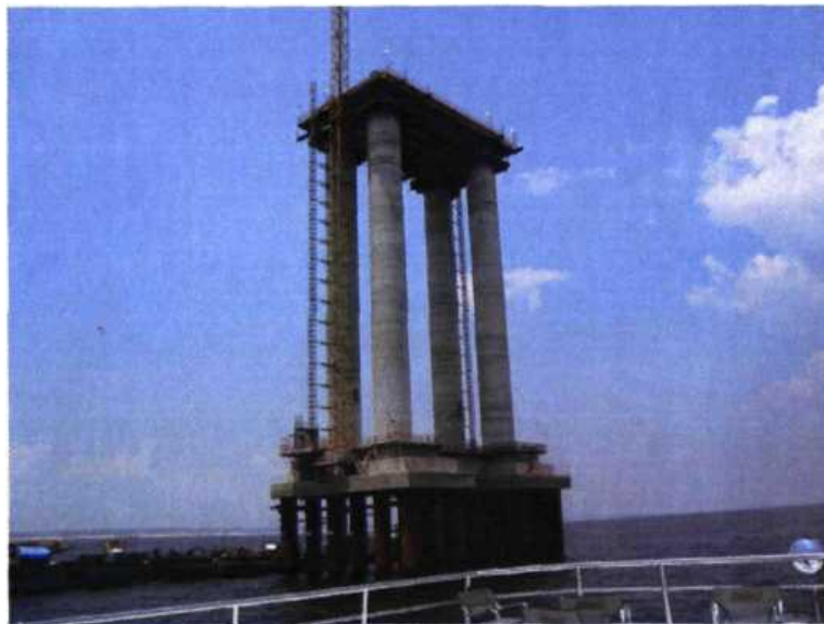
Рисунок 1.14 – Трубобетонні мега-опори моста «Manaus-Iranduba»
