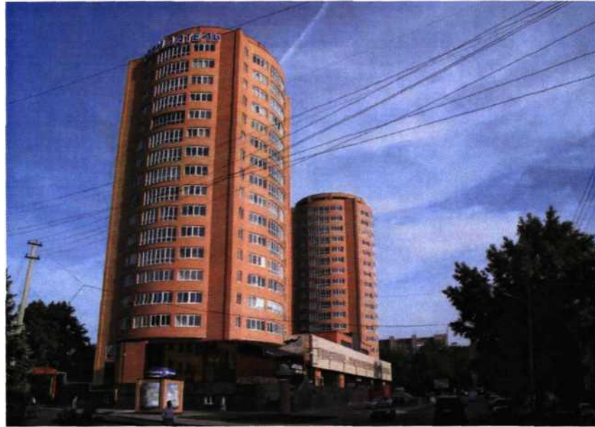
Рисунок 1.15 – Житлові 17 поверхові будинки на Україні з застосуванням в металевому каркасі трубобетонних стійок
