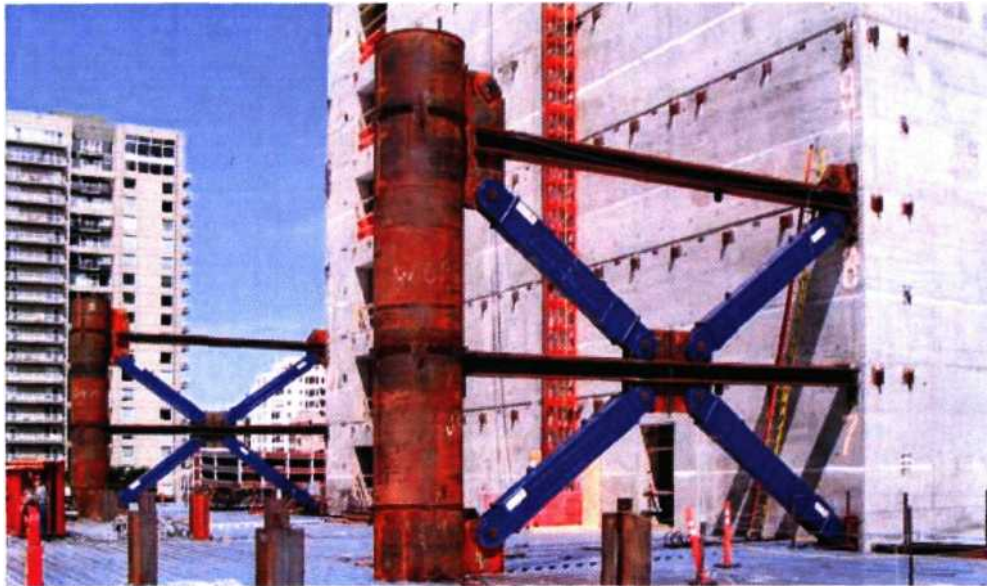
Рисунок 1.10 – «Сейсмічний запобіжник» з трубобетонних елементів
