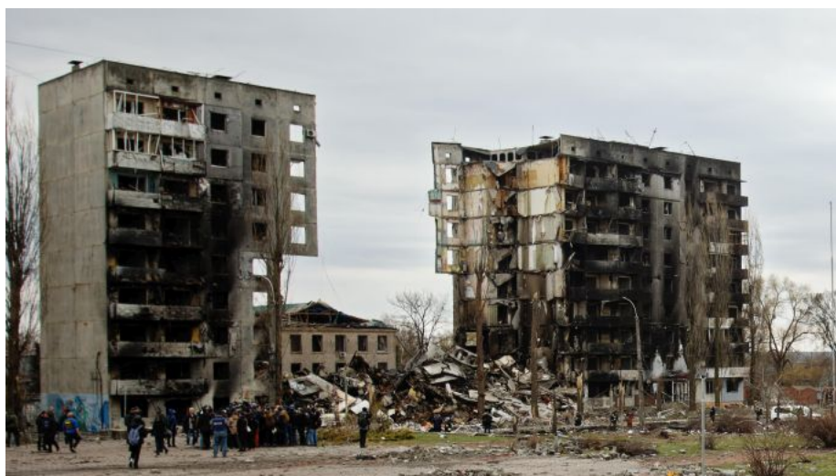
Рис. 2.2.4 Фото зруйнованої багатоповерхівки в Бородянці Київської області з матеріалу під назвою «На Київщині зруйновано близько 5 тисяч будинків» (УП від 27.05.2023)
