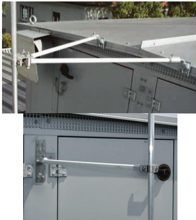
Рисунок А.4 – Кріплення стрижня блискавкоприймача за допомогою додаткових склопластикових тримачів
