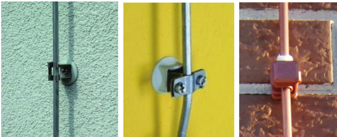
Рисунок А.20 – Кріплення струмовідводів до стіни
