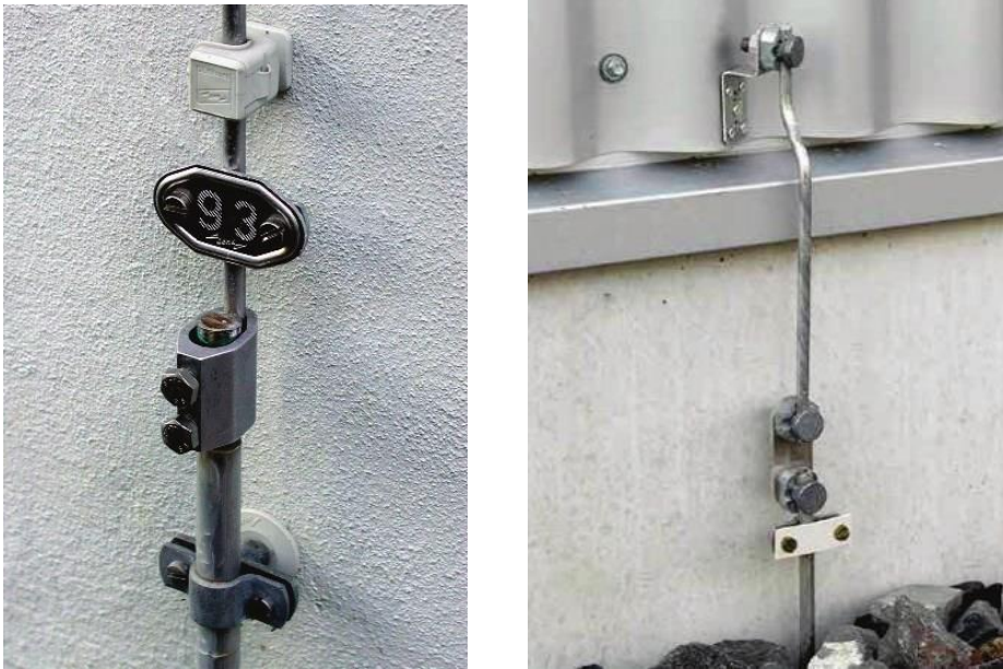
Рисунок А.19 – Приклади влаштування контрольних точок заземлення
