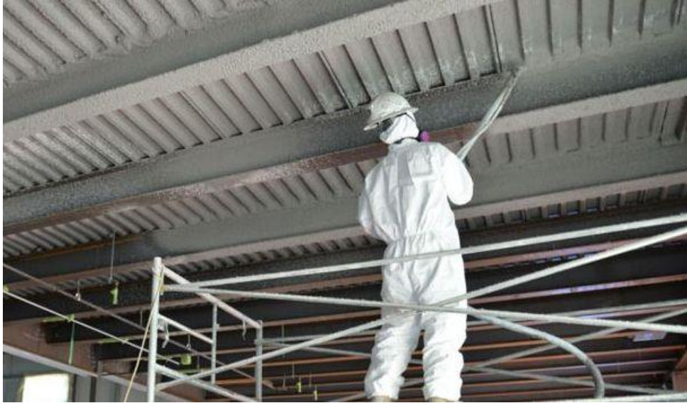
Рисунок 1.3 – Металеві будівельні конструкції оброблені штукатурним вогнезахисним покриттям
