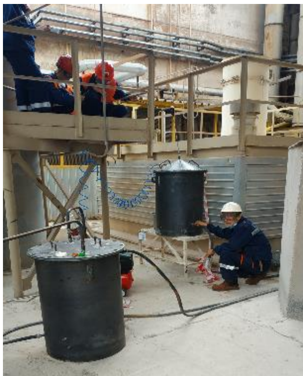
Рисунок 3.5 – Зовнішній вигляд установки на даху біля труби печі
