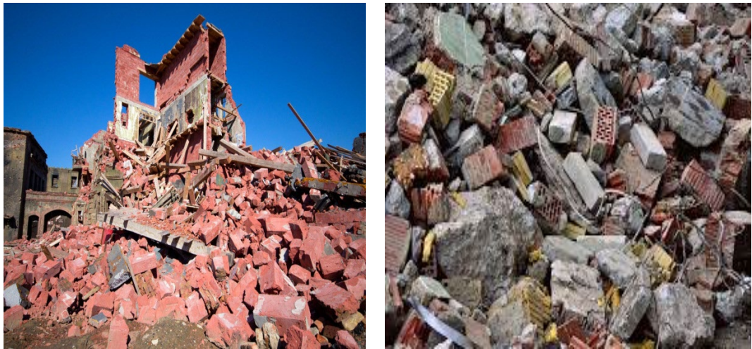
Рисунок 1.1 – Будівельні відходи, знесених будівель
