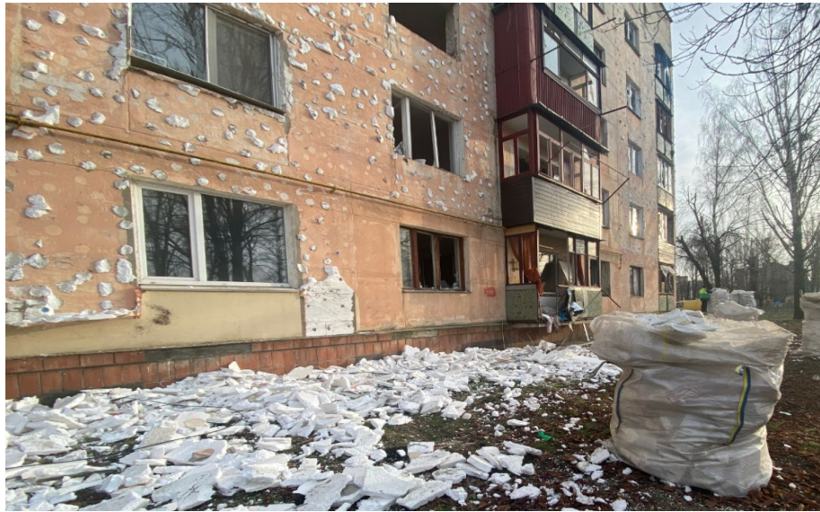
Рисунок 4.9 – Демонтаж зруйнованих будинків
