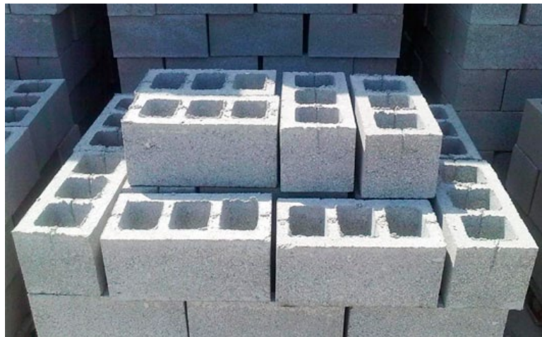
Рисунок 3.1 – Шлакоблок пустотілий
