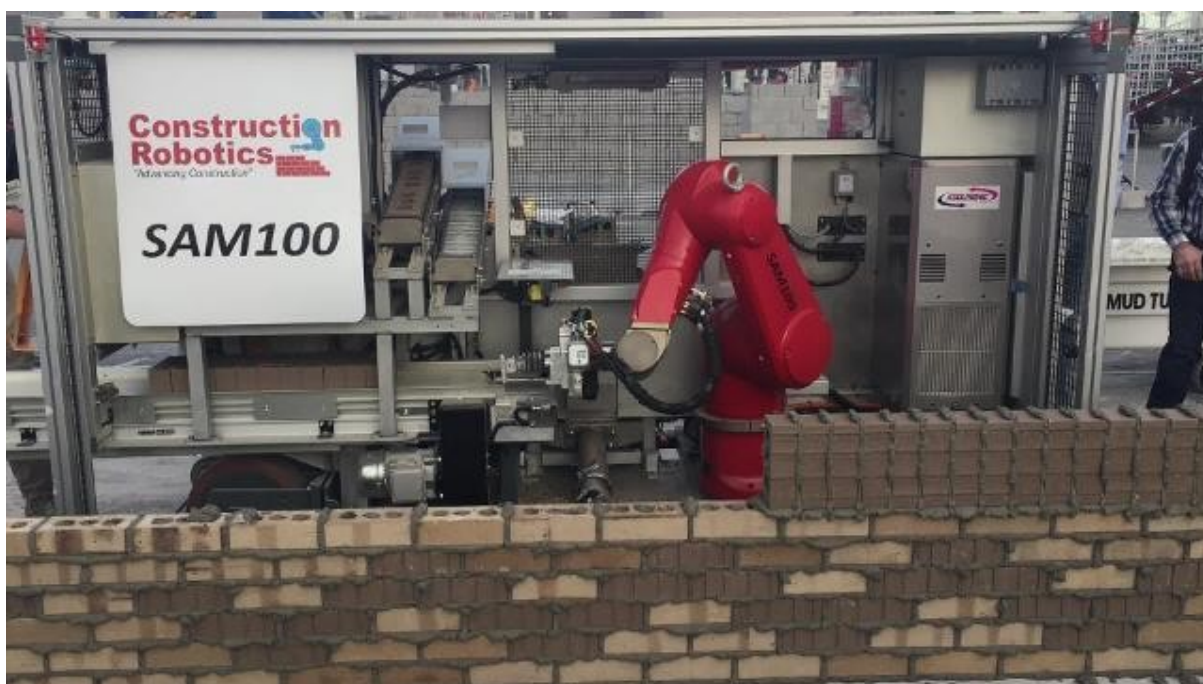
Рисунок 1.5 — Робот SAM100 (Semi-Automated Mason)
