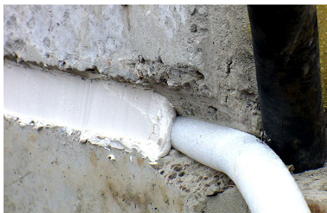
Рисунок 2.7 – Детальний вид герметизації міжпанельних швів
