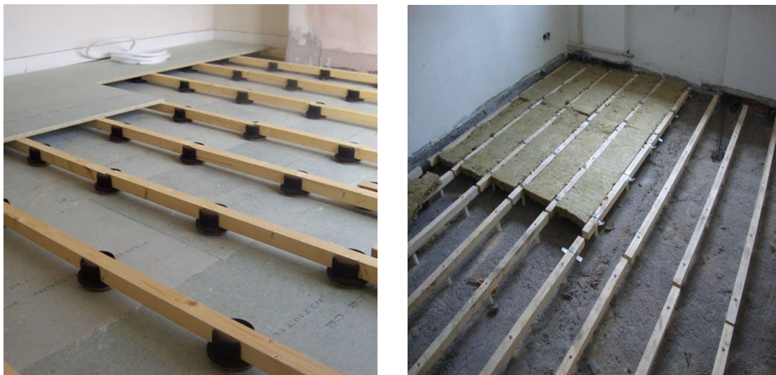
Рисунок 3.17 – Влаштування підлоги на лагах
