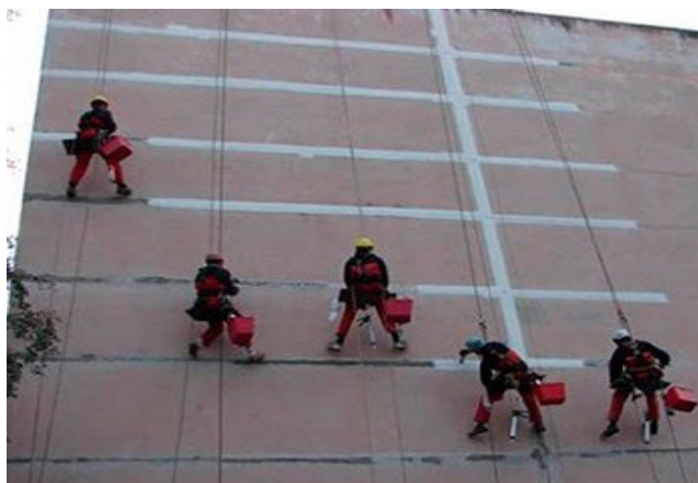
Рисунок 2.6 – Приклад виконання герметизації міжпанельних швів
