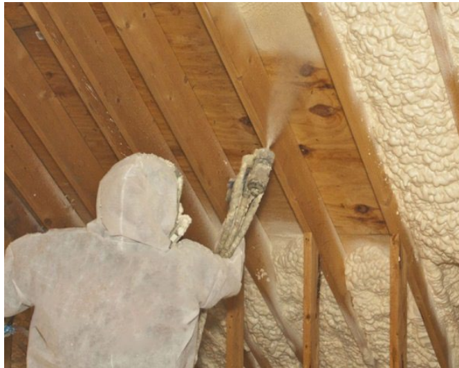
Рисунок 2.13 – Утеплення даху пінополіуретаном
