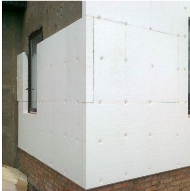
Рисунок 2.8 – Утеплення фасаду пінопластом
