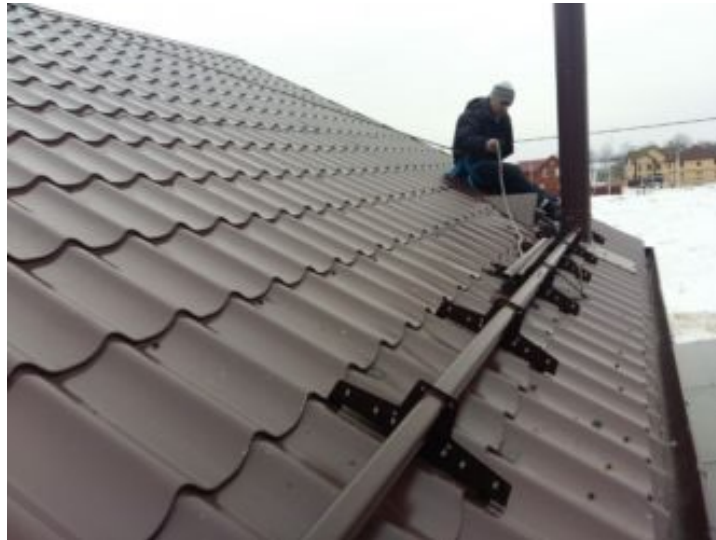
Рисунок 2.7 – Влаштування снігоутримувача на даху
