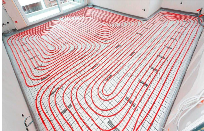
Рисунок 2.14 – Влаштування теплої підлоги
