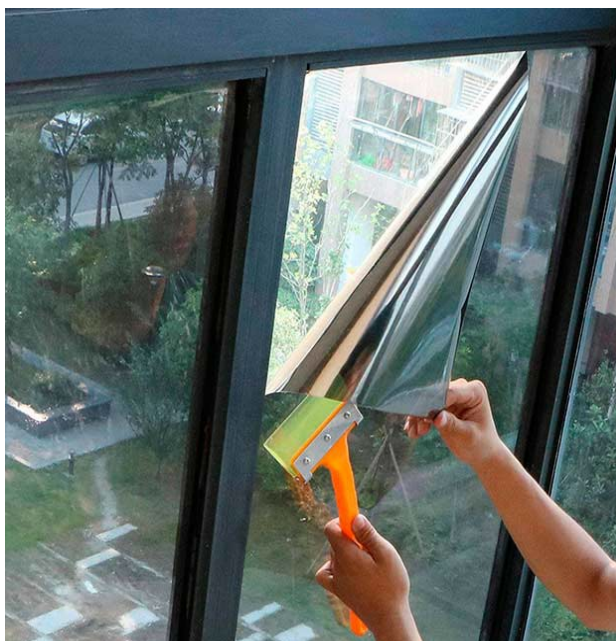
Рисунок 2.15 – Використання сонцезахисної плівки на вікні
