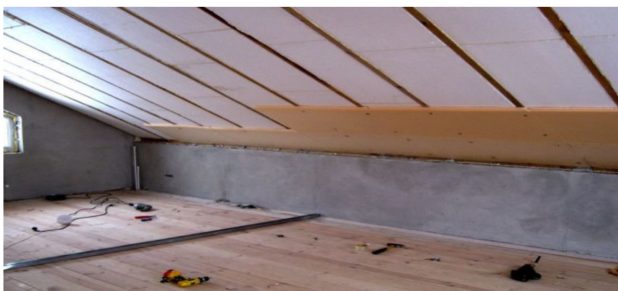
Рисунок 2.12 – Утеплення даху пінопластом
