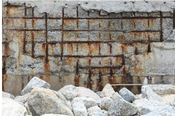
Рисунок 3.6 – Вид раку бетонних конструкцій
