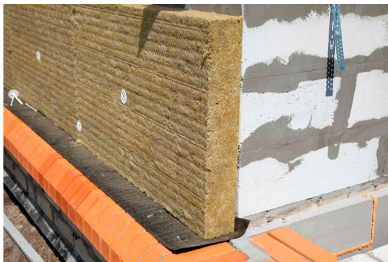
Рисунок 2.17 – Утеплення стіни мінеральною ватою
