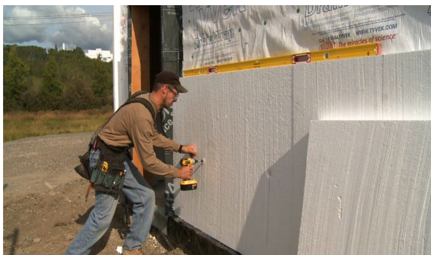
Рисунок 2.18 – Утеплення полістирольним пінопластом (EPS)
