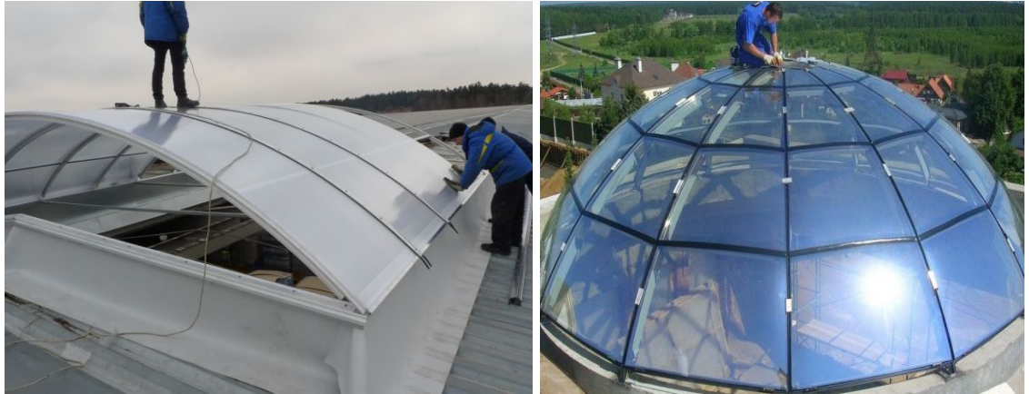
Рисунок 2.8.1 – Світлові купола на металевій покрівлі
