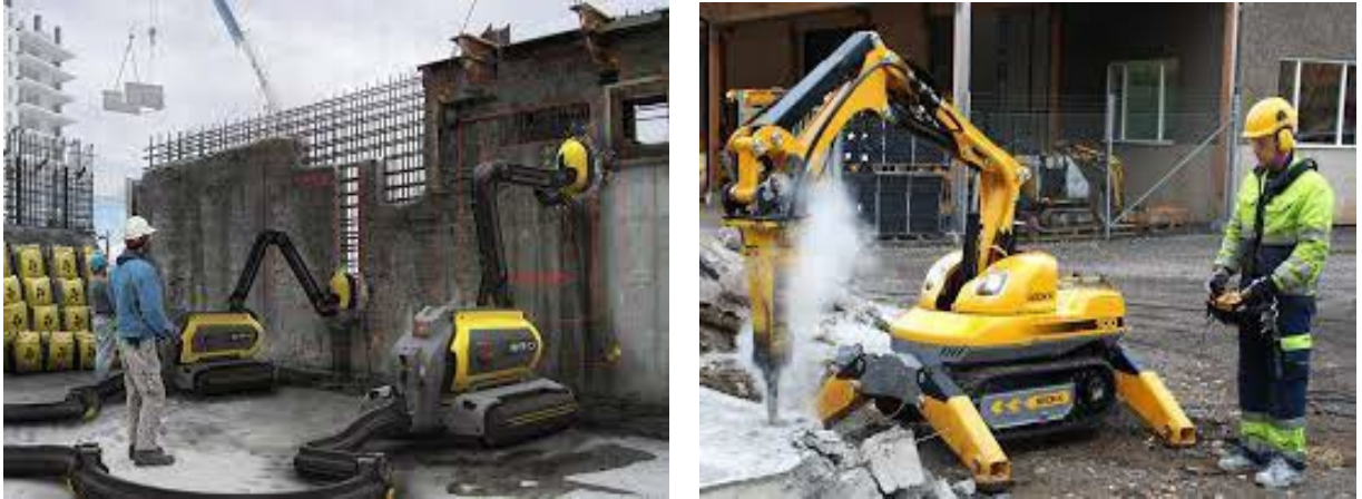
Рисунок 1.5 – Приклади використання робототехніки в будівництві
