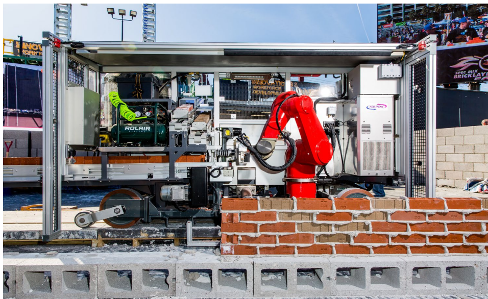
Рисунок 4.2 – Вид робота-муляра SAM100
