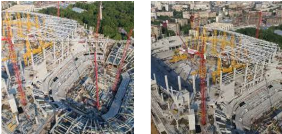
Рисунок 1.4 – Приклад аерозйомки будівельного процесу
