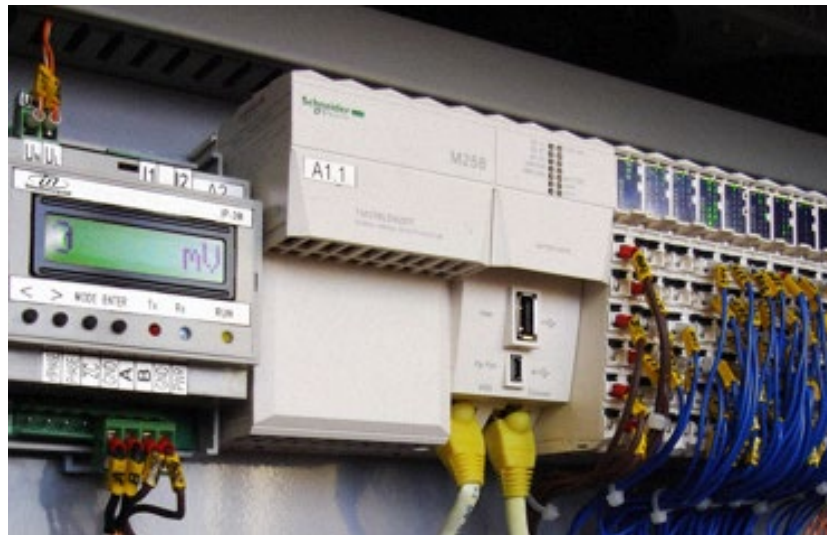
Рисунок 1.6 – Система обліку енергоспоживання в будинку
