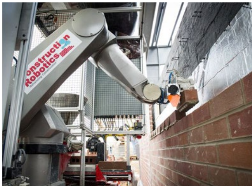
Рисунок 4.1 – Виконання цегляної кладки роботом-муляром SAM100
