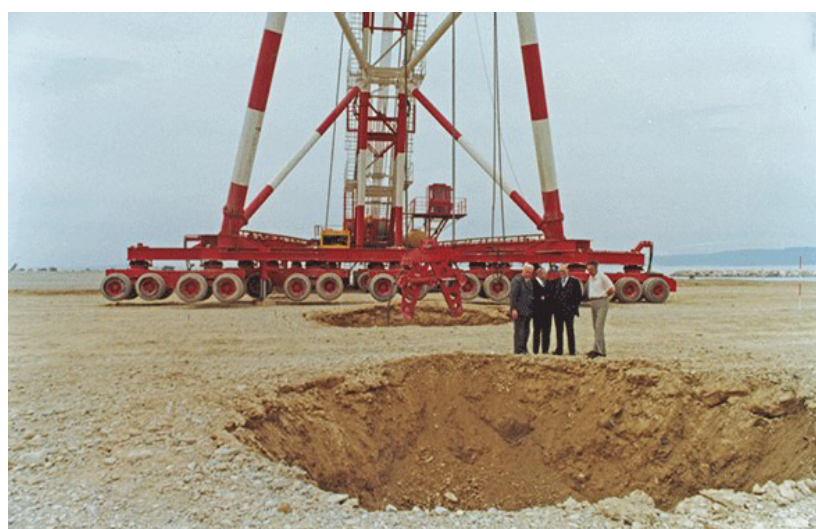
Рисунок 1.8 – «Giga-machine» на будівельному майданчику аеропорту м. Ніца
