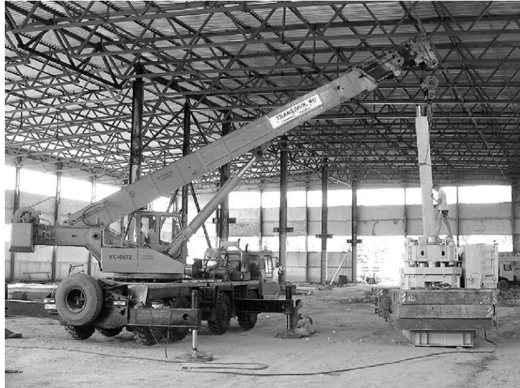
Рисунок 3.3 – Вдавлення палі точковим способом під перекриттям існуючого промислового будинку із застосуванням машини C0-450
