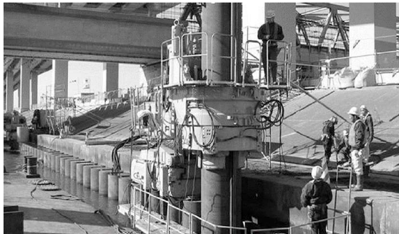
Рисунок 1.21 – Вдавлювання труб машиною «TubularPiler» при реконструкції гідротехнічної споруди
