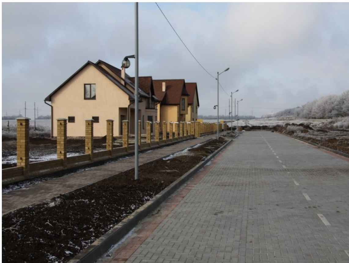
Рисунок 3.10 – Будівництво котеджів у селищі Сонячне
