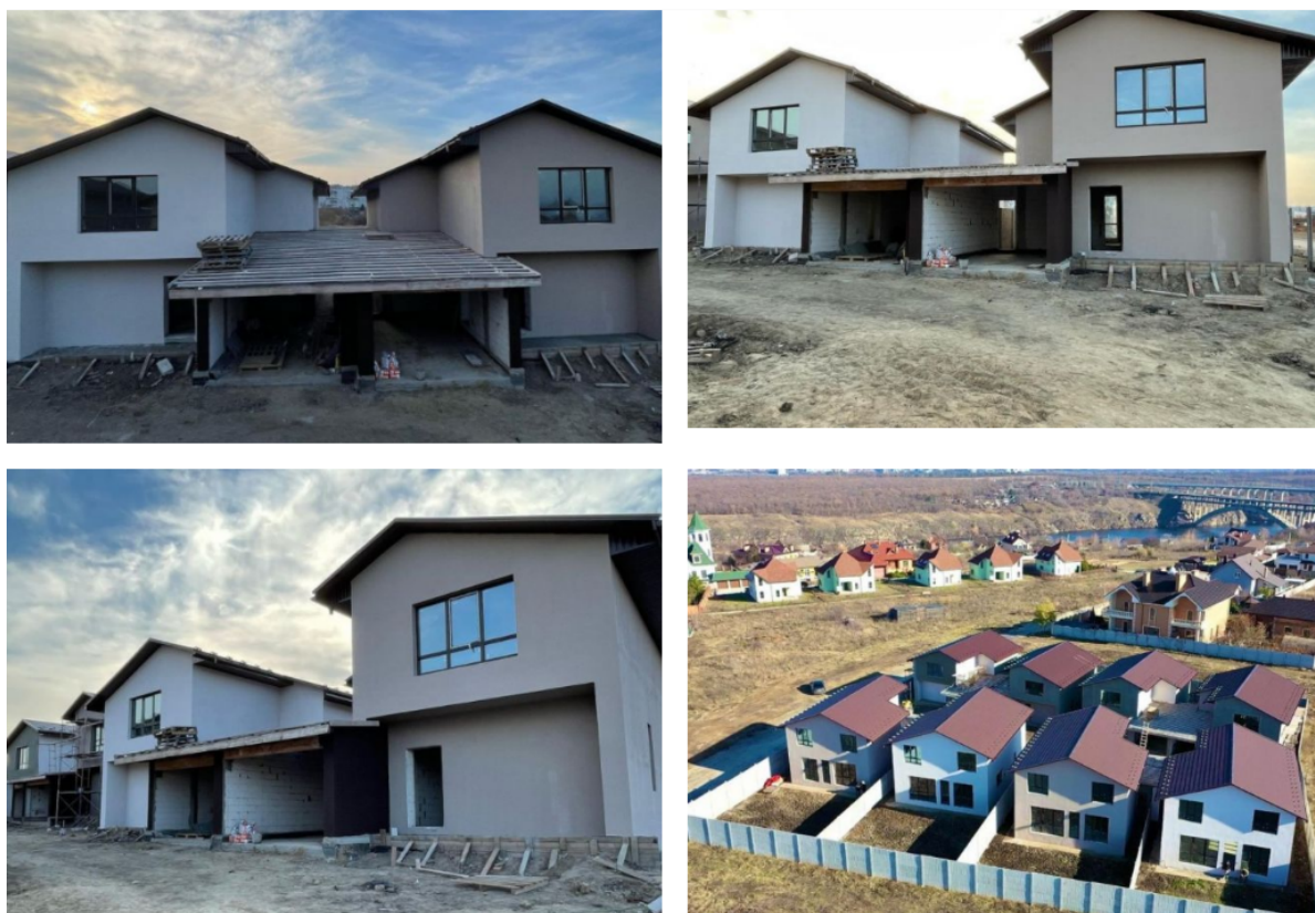
Рисунок 3.8 – Хід будівництва селища-передмістя Запоріжжя
