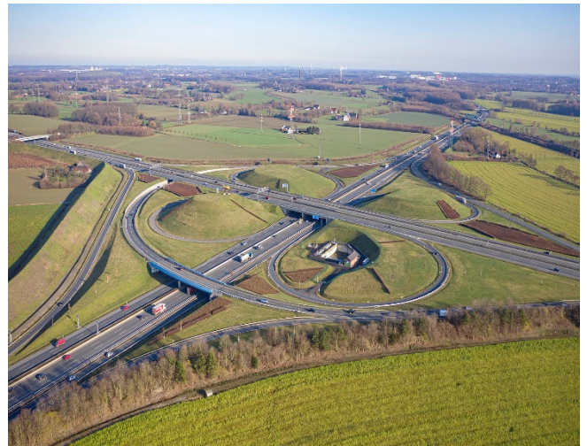
Рисунок 1.2, б – Насипи з ґрунту, непридатного для використання, та споруда для очищення зливових вод
