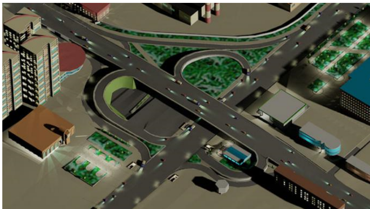
Рисунок 3.6 – Трирівнева транспортна розв'язка з реверсним розподільчим кільцем
