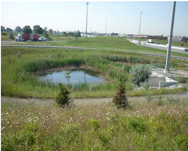
Рисунок 1.2, а – Ставок-відстійник у петлевій рампі (перехрестя HWY427 і Rexdale Blvd, Онтаріо)
