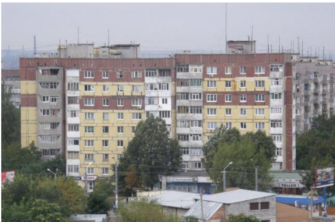
Рисунок 2.4 – Серія 87 типових проектів 9-ти поверхових житлових будинків зі стінами із блоків
