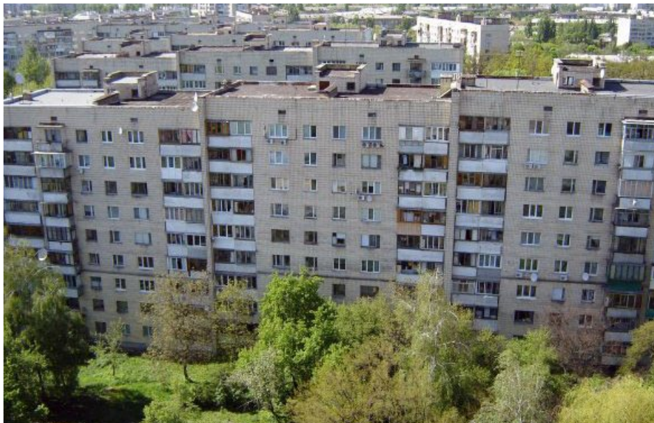
Рисунок 2.2 – Серія 87 типових проектів 9-ти поверхових житлових будинків зі стінами із цегли
