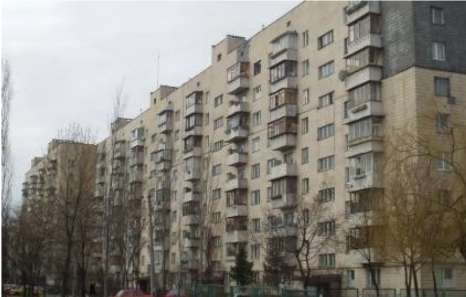
Рисунок 2.1 – Серія 87 – будинок зі стінами з цегли
