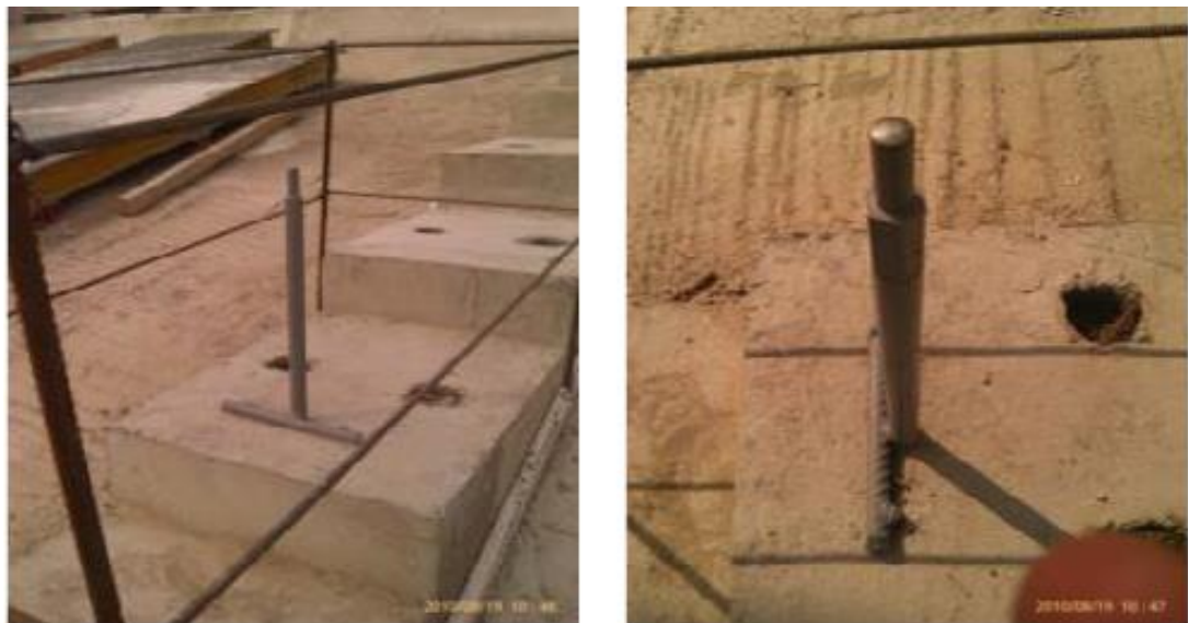
Рисунок 3.4 – Загальний вигляд пункту мережі S76 перед установленням складок нижнього ярусу трибун
