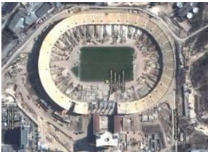
Рисунок 3.1 - Зовнішній вид стадіону зверху на початок реконструкції
