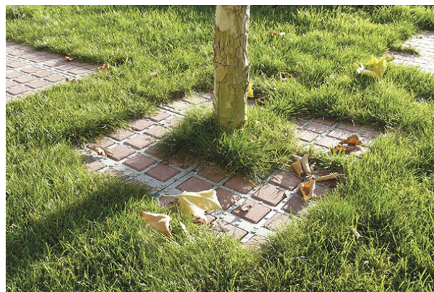
Захист лунок дерев від витоптування та пошкодження транспортом
