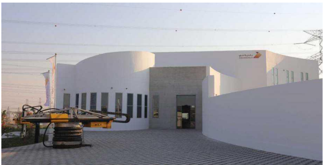
Рисунок 1.2 - Результат будівельного 3D друку в ОАЕ
