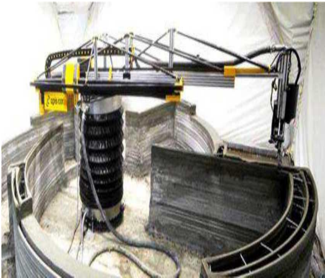
Рисунок 1.4 – Будівельний 3D принтер маніпуляторного типу компанії Apiscor
