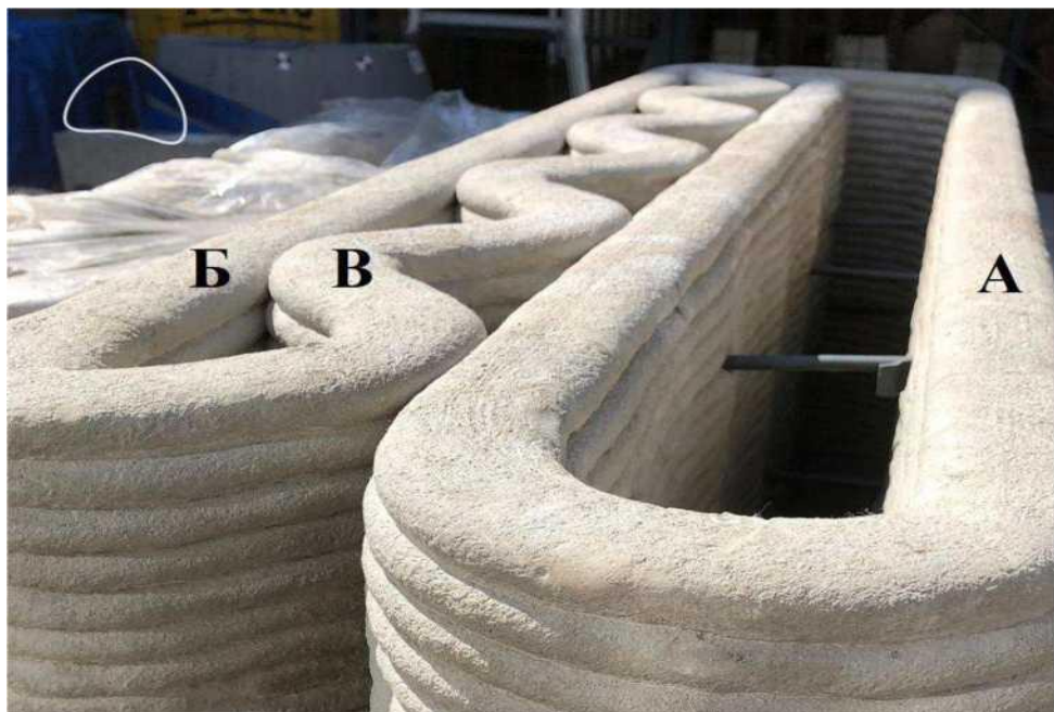
Рисунок 3.19 - Приклад стінової конструкції
