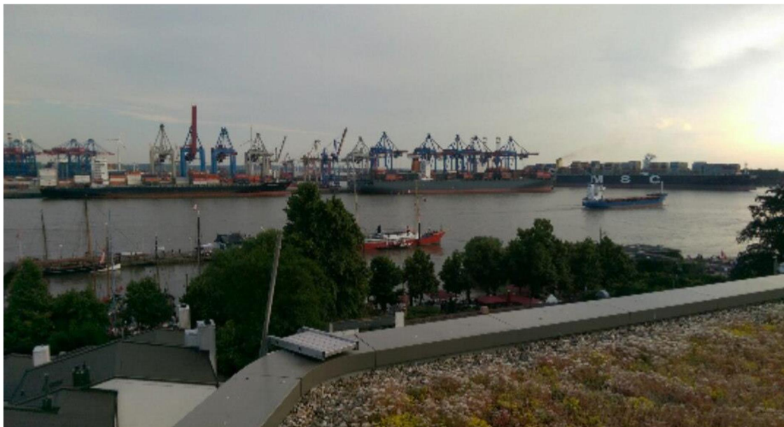
Рисунок 1.1 – Системи «зеленої» покрівлі, побудовані в Гамбургу, Німеччина
