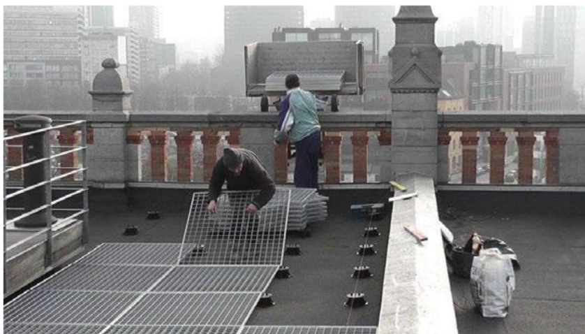
Рисунок 3.6 – Влаштування ґратчастого настилу на опори
