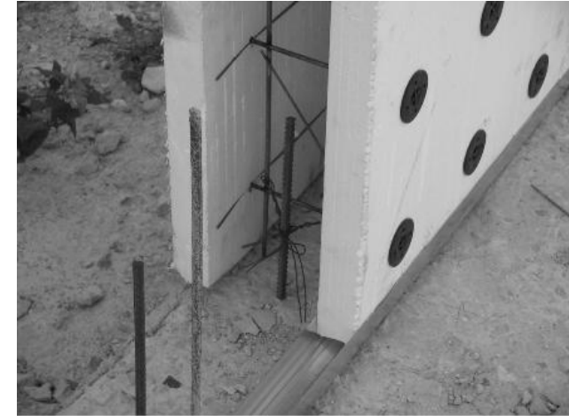
Рисунок 2.5 - Конструктивні елементи системи PLASTBAU:
