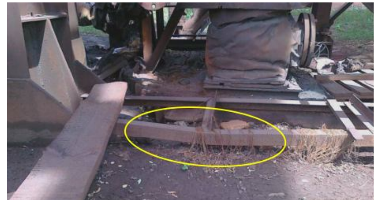
Рисунок 3.16 - Характерне ушкодження - руйнування зварних швів кріплення проміжних прокладень складових елементів в конструкції зв'язків, опора К- 5 вісь 5. Профіль траси 2-7. Категорія ушкодження по [34] - А, група 4.12, таблиця 10
