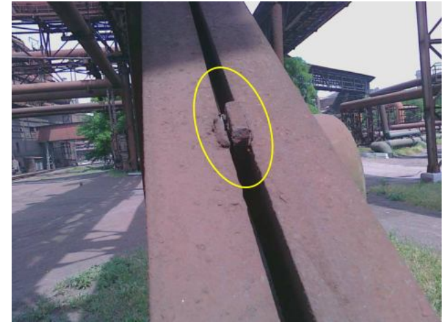
Рисунок 3.16 - Характерне ушкодження - руйнування зварних швів кріплення проміжних прокладень складових елементів в конструкції зв'язків, опора К- 5 вісь 5. Профіль траси 2-7. Категорія ушкодження по [34] - А, група 4.12, таблиця 10
