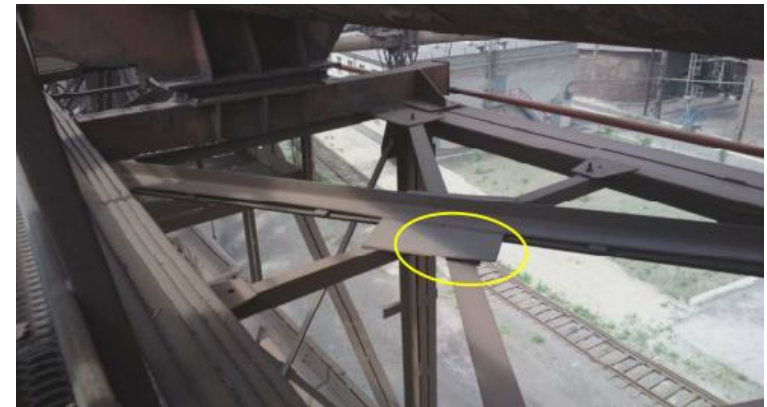
Рисунок 3.1 - Характерне ушкодження - руйнування зварного шва кріплення фасонки до гілки горизонтального зв'язку пролітної будови. Профіль траси 2-7. Категорія ушкодження по [34] - А, група 4.12, таблиця 10
