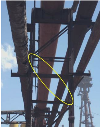
Рисунок 3.18 - Виріз розкосів грат опори K8 по осі 440. Профіль траси 433-455. Категорія ушкодження по [34] - А, група 1.1, таблиця 10
