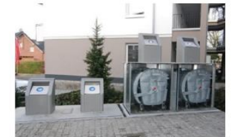
Фото. Завантаження контейнерів підземного розташування
