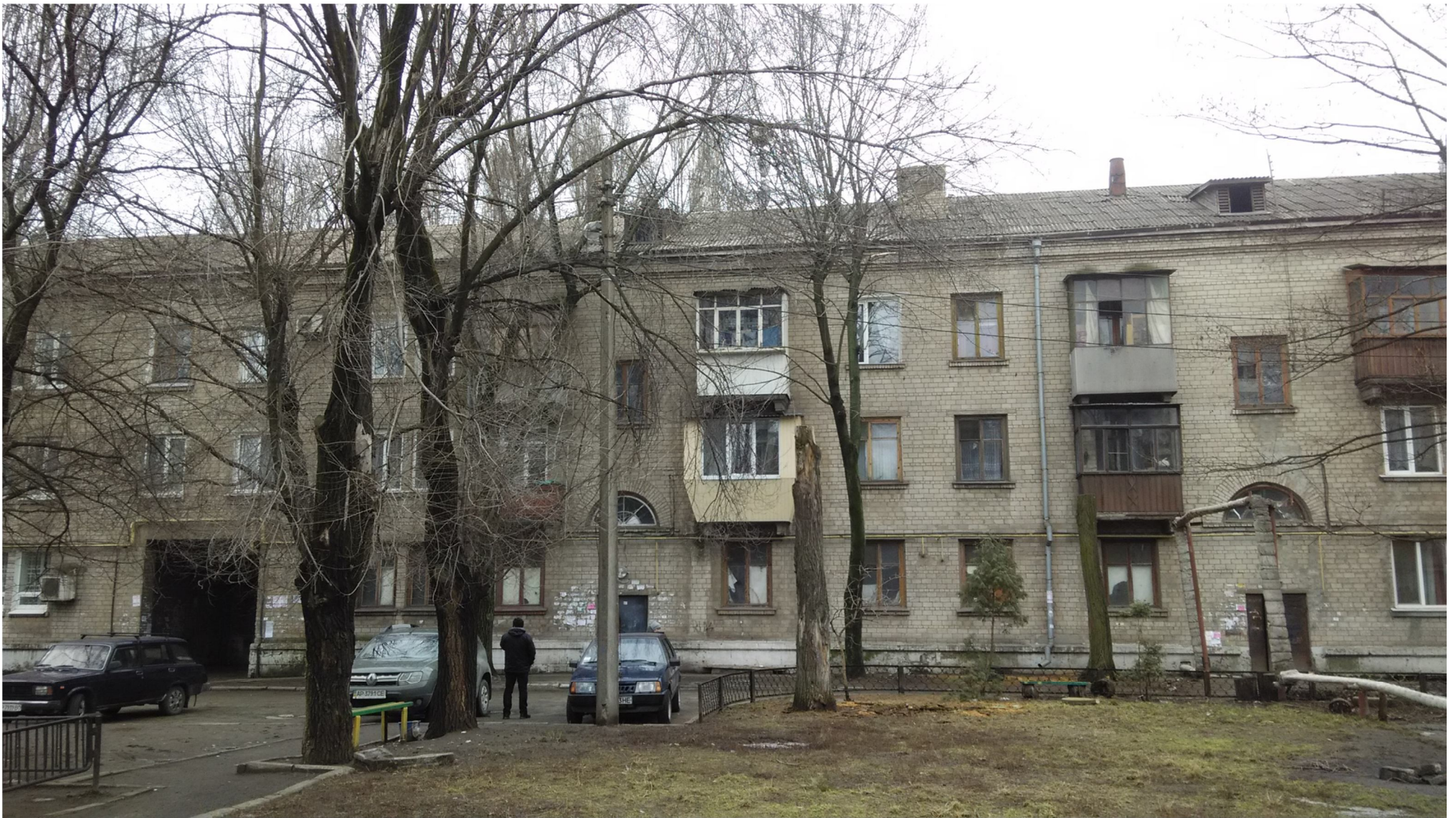
Рисунок 36 – Загальний вигляд будівлі з боку дворового фасаду.
