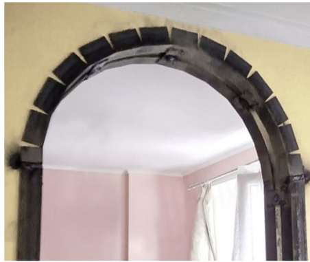
Рисунок 27 - Складне армування з куточка.
