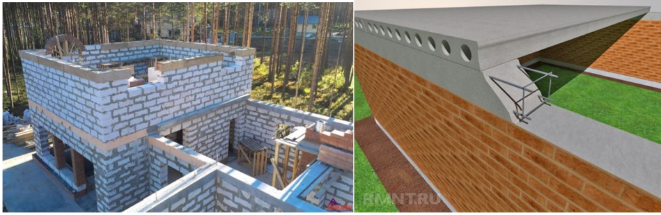
Рисунок 30 – Приклад залізобетонних поясів жорсткості
