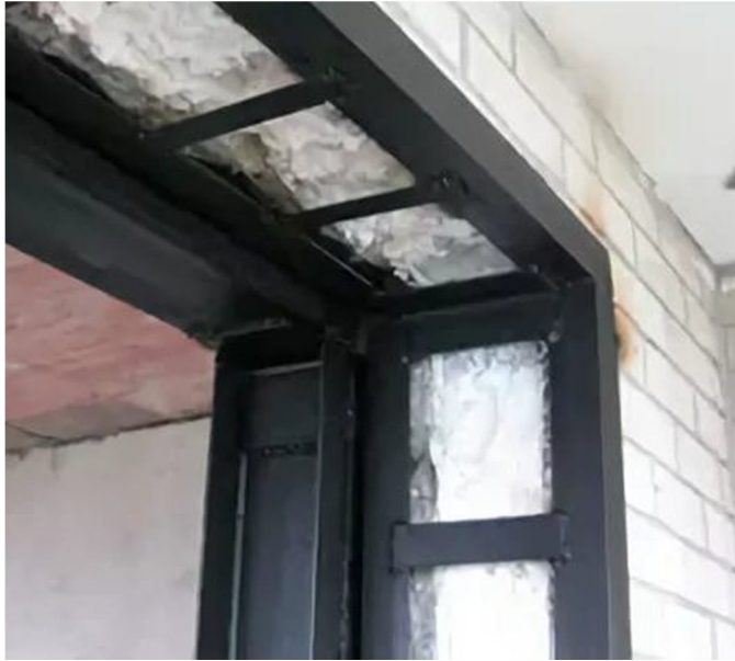
Рисунок 29 – Комбінування видів посилення
