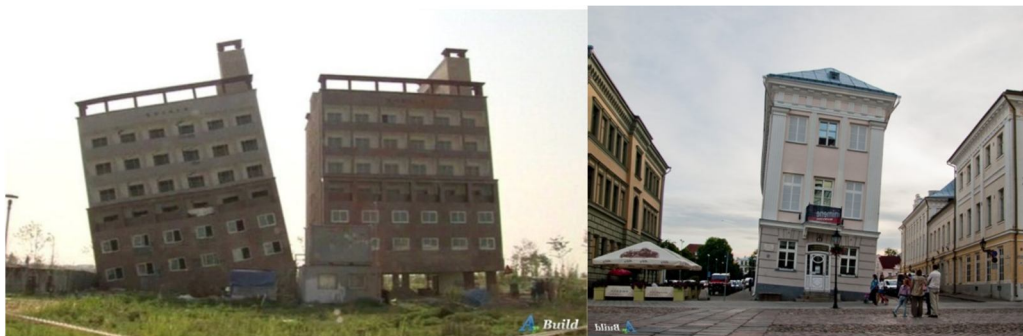
Рисунок 7 - Нерівномірні осадження будівель
