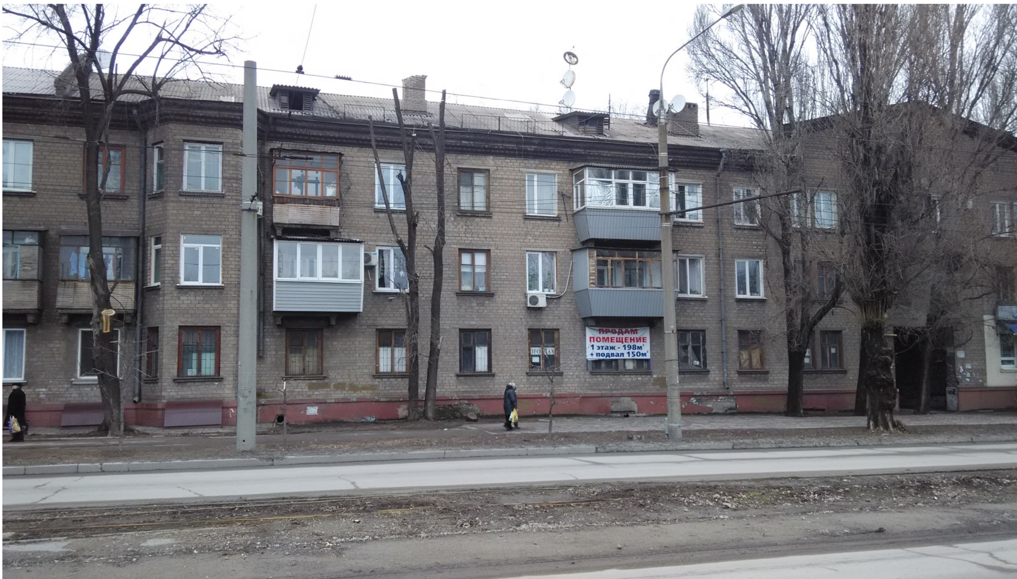
Рисунок 35 – Загальний вигляд будівлі з боку головного фасаду.
