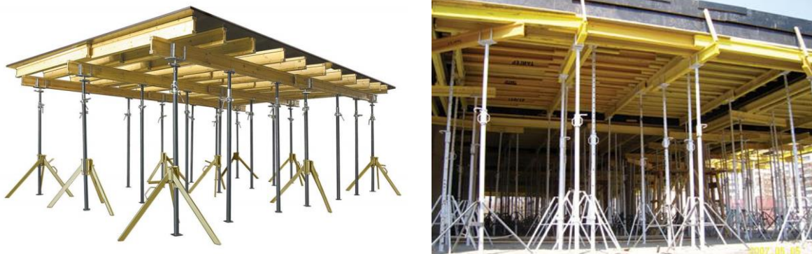
Рисунок 2.4 - Опалубка перекриття на телескопічних стійках
