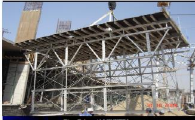
Рисунок 1.6 – Алюмінієва опалубочна система для зведення плит перекриття будинків
