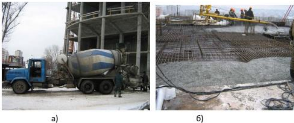
Рисунок 1.10 - Розвантаження бетонної суміші в бункер і її укладання бетононасосною установкою з розподільчою стрілою:
