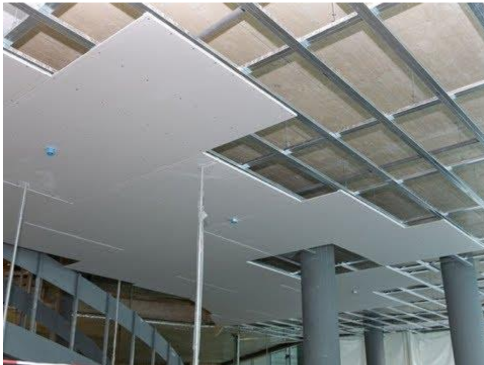
Рисунок 1.6 – Конструкція підвісної захисної стелі
