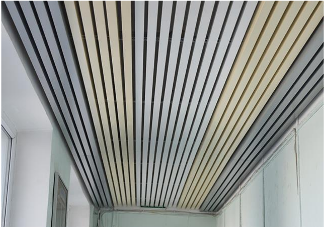
Рисунок 1.7 - Влаштовано підвісна стеля
