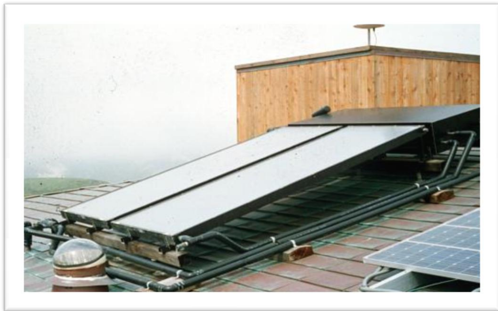
Рисунок 1.1 - Теплова система нагрівання води
