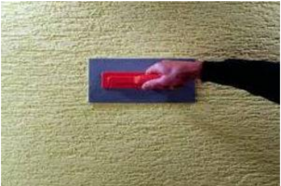
Рисунок 2.5 - Зразок фактури фасадної декоративної штукатурки
