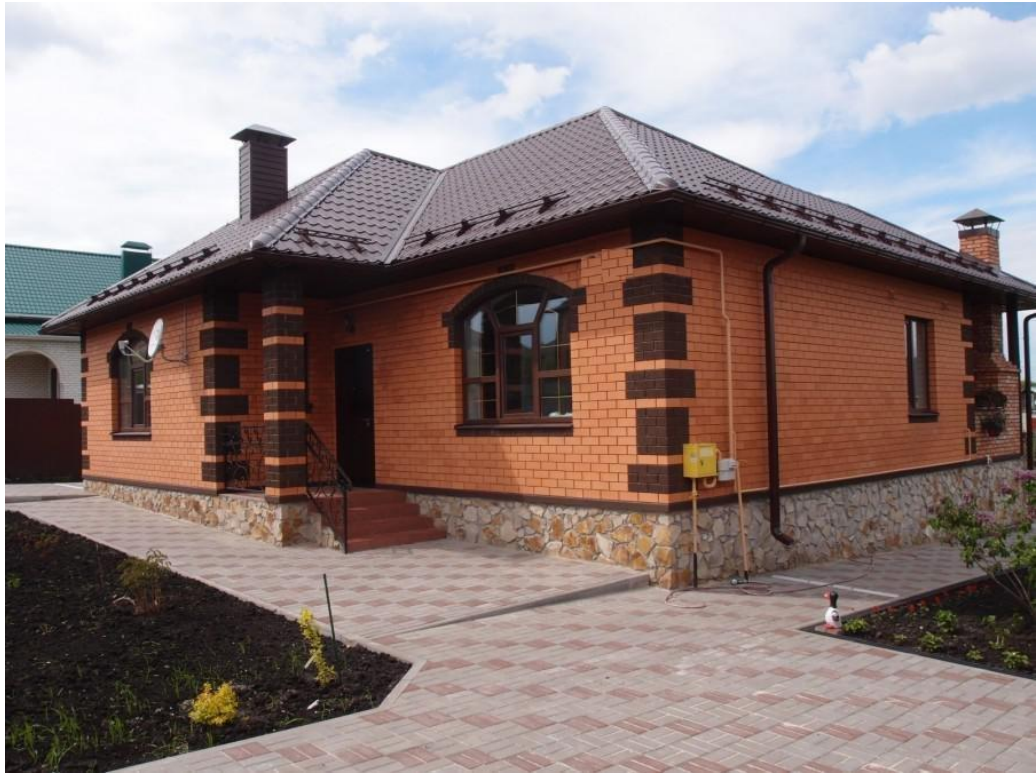
Рисунок 2.11 - Фасад приватного будинку облицьованого цеглою
