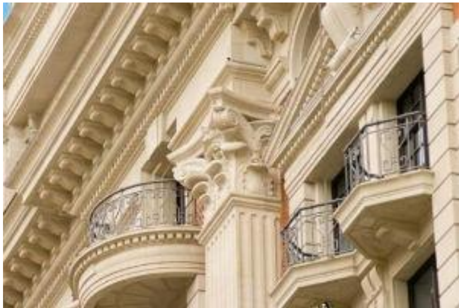
Рисунок 2.26 - Фасад з архітектурного каменю
