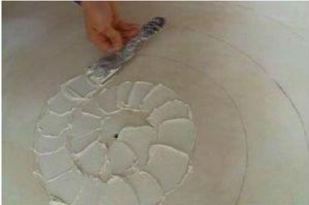
Рисунок 2.2 - Зразок нанесення акрилової фасадної штукатурки
