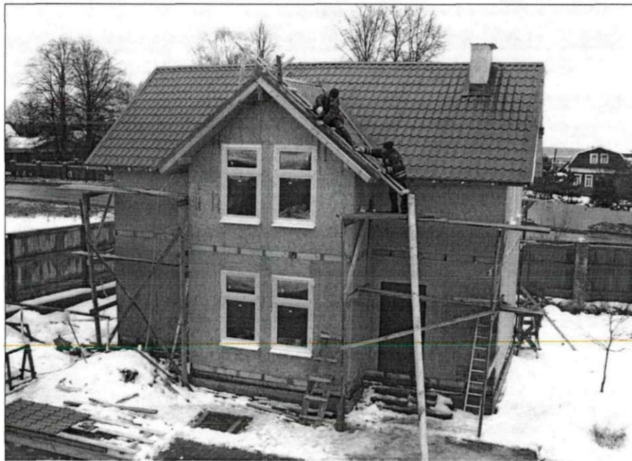
Рисунок 3.17 - Зовнішнє оздоблення котеджу, зведеного за експериментальною технологією з швидкозбірних сендвіч-панелей
