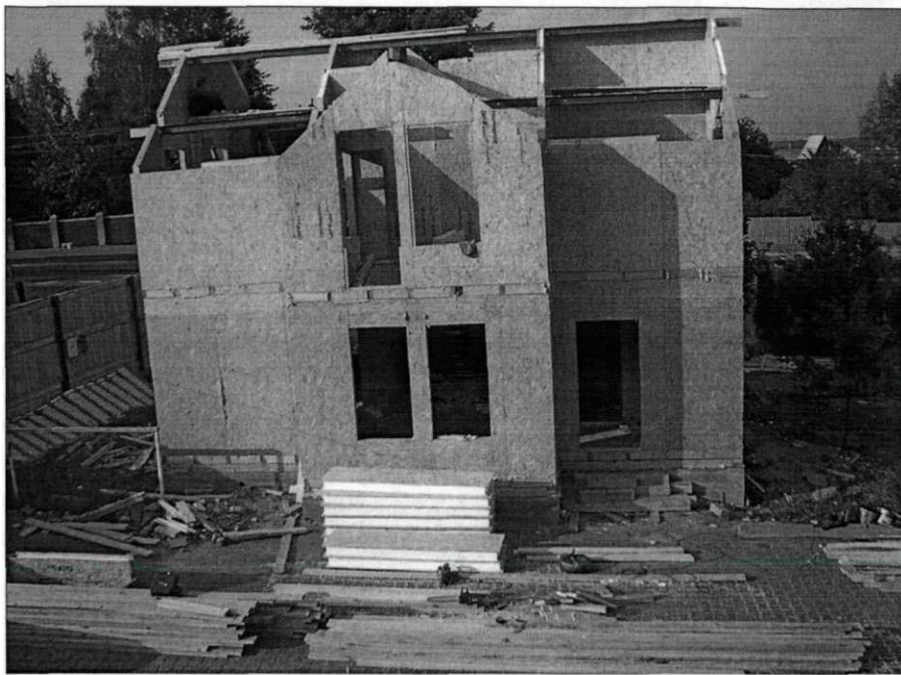
Рисунок 3.15 - Влаштування каркаса і стін горищного простору з сендвіч-панелей
