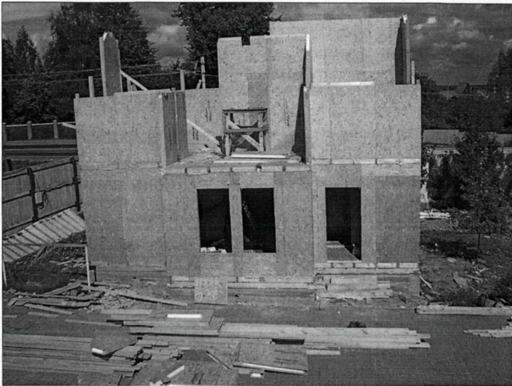
Рисунок 3.14 - Установка панелей перегородок із сендвіч-панелей
