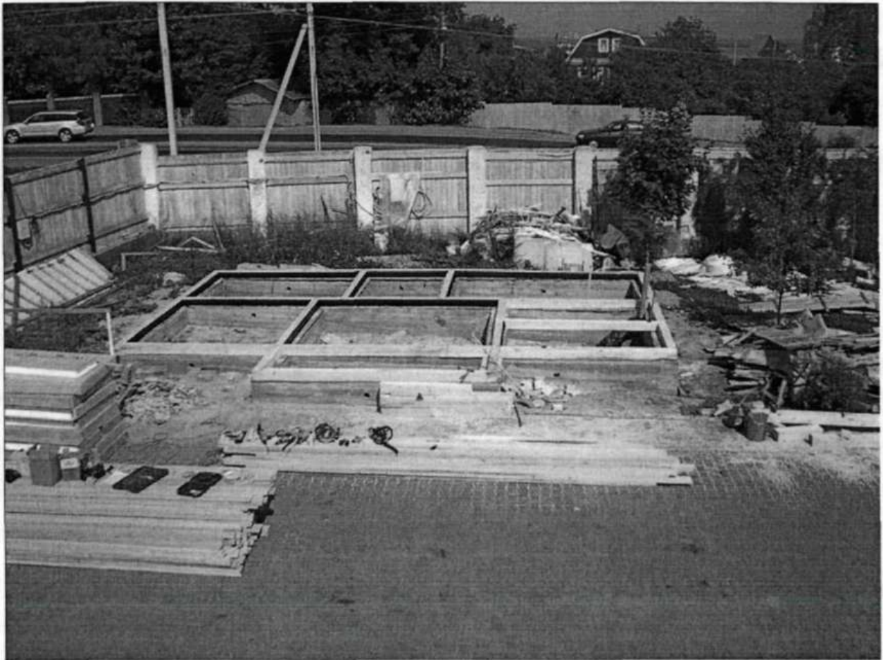
Рисунок 3.10 - Влаштування стрічкового бетонного фундаменту під експериментальний котедж
