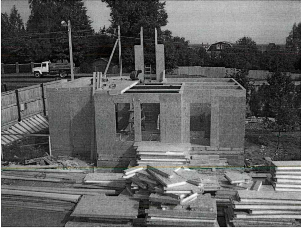
Рисунок 3.13 - Установка зовнішніх стінових панелей 2 поверху з сендвіч-панелей
