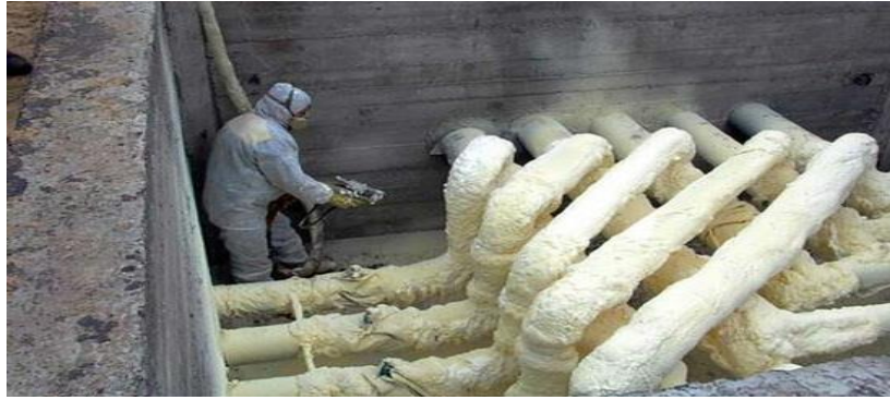
Рисунок 1.4 - Утеплення труб піноізолом
