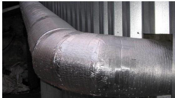
Рисунок 1.5 - Труба, утеплена фольгованим пінофолом
