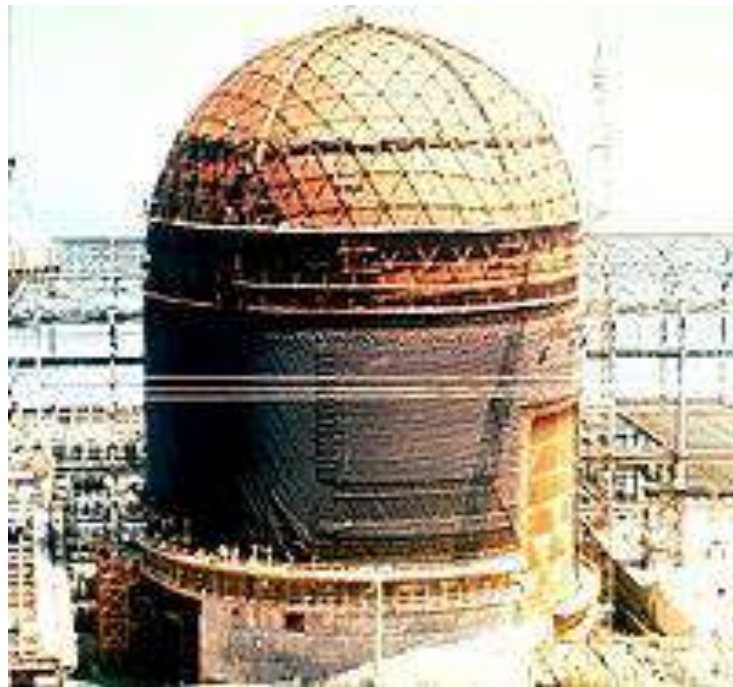
Рисунок 2.2 – Контейнмент у процесі монтажу
