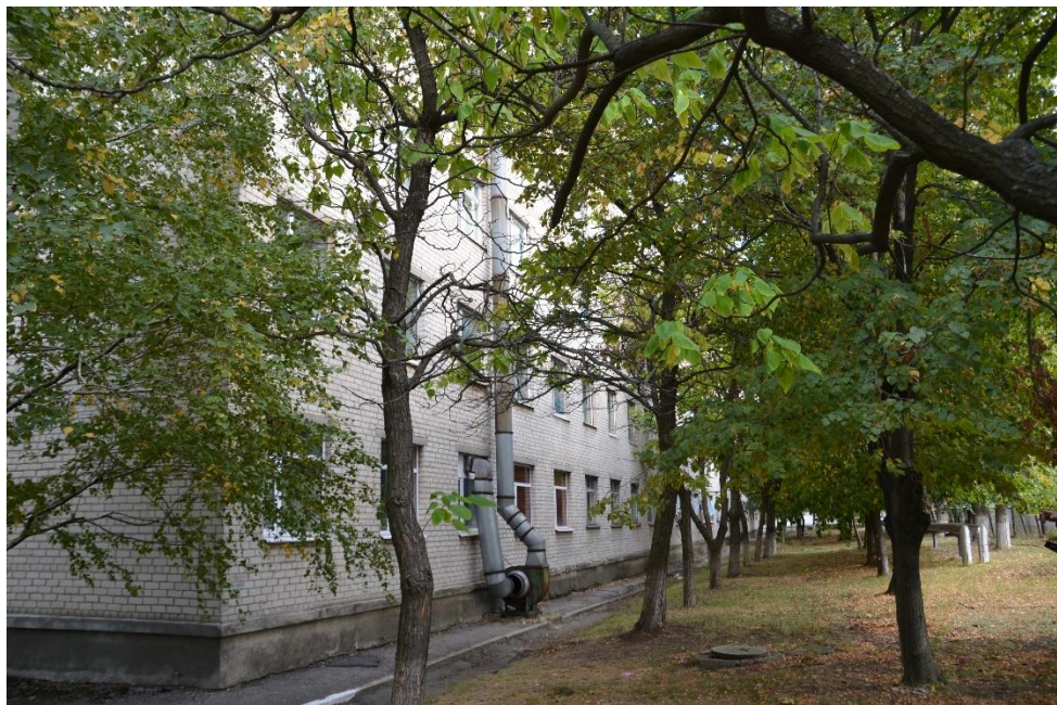
Рисунок 2.3 – Фотографія цокольної частини будівлі
