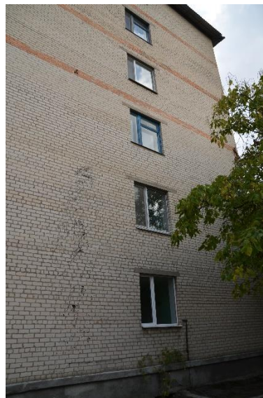
Рисунок 2.1 – Фотографія стін будівлі
