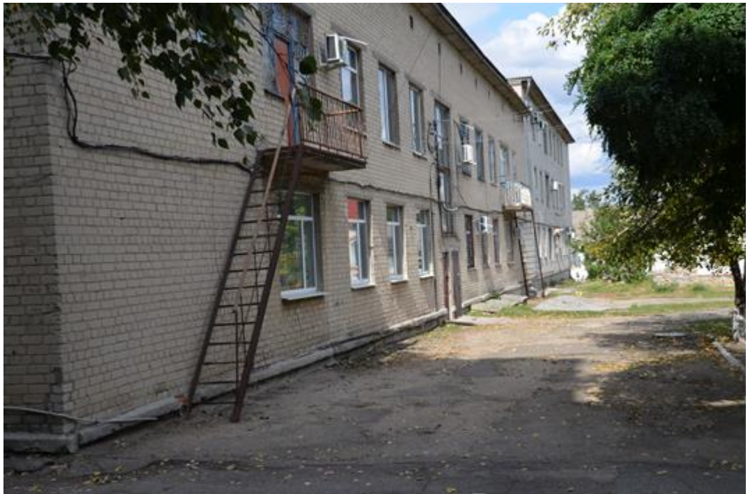
Рисунок 2.2 – Фотографія стін будівлі
